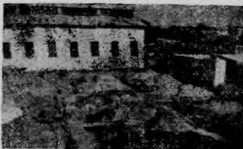
本校第一期校舍建築基地
