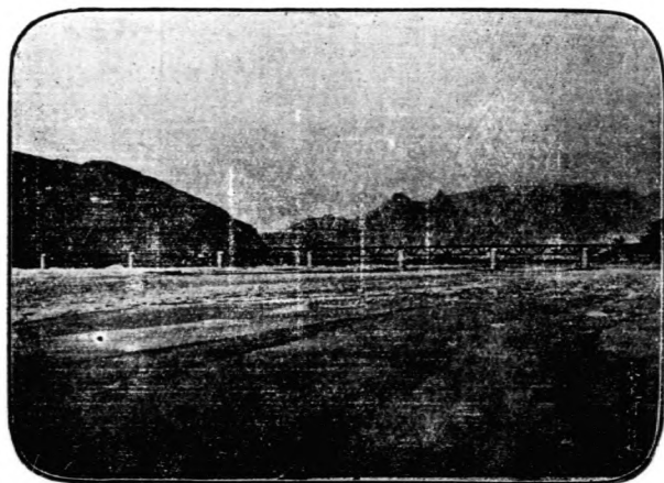
東永溝 大定河 橋
