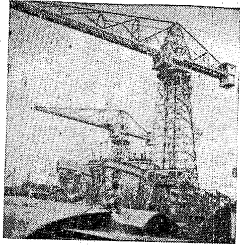
某造船公司造船廠瓦工場，工人正在利用這種方法工作。
