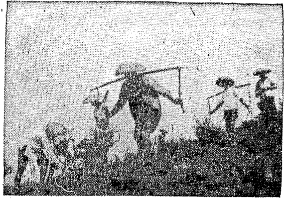
為了保證豐收，目前瀟湖地區的廣大人民，正在黨和人民政府的領導下，積極進行各項防汛準備工作。這是漢壽縣城大堤的農民，正在挑土補修堤防的情形。
