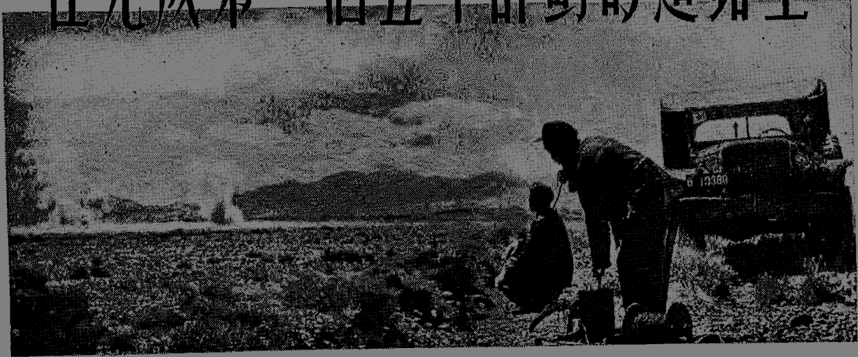
△ 探明足夠的地下礦產是建設現代工業的先行步驟。在我國西北的酒泉盆地，今年的普查和勘探的投資比去年增加將近一倍。圖為地球物理探礦隊的隊員們正在使用人工地震的方法，尋找含油岩石。 新華社記者姚宗儀攝
