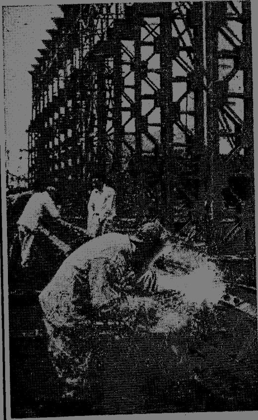
△ 大冶鋼廠正在進行擴建。它的平爐擴建工程廠房高大，結構複雜。來自各地的鋼鐵工人正在積極工作，爭取按期完成預製鋼柱的任務。 新華社記者王純德、胡偉攝
