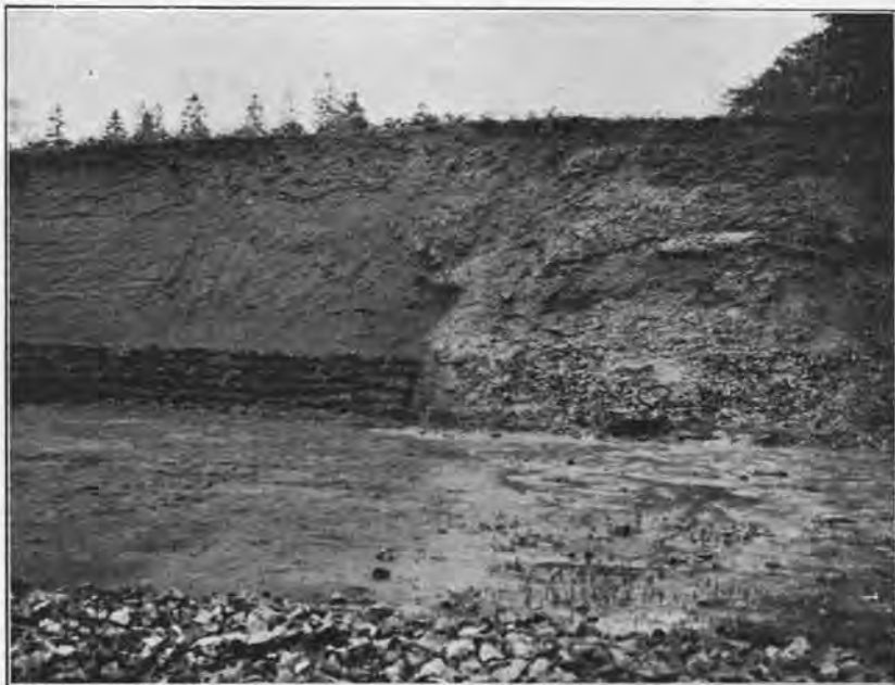
Fig. 350. M6. Faille dans la gare de Bonnert. A gauche, en partie couvert par des mottes de gazon, sable virtonien. A droite, marne virtonienne. La ligne de rupture se remarque aussi dans le sol : à gauche, sable sec; à droite, marne couverte d'eau. Juin 1909.
