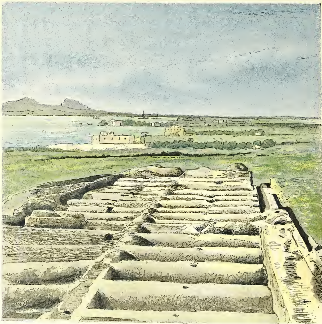
Citernes de Carthage dans leur ancien état.
