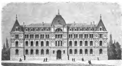
Fig. 5. Baugewerkschule in Gießen, erbaut von Carl Gotthard v. Langhans.
