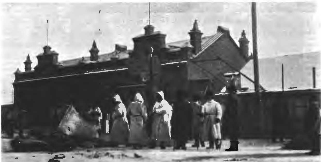
Г. Харбинъ, Монгольская улица. Дезинфекціонная колонна. Сжиганіе вещей изъ чумнаго дома.
