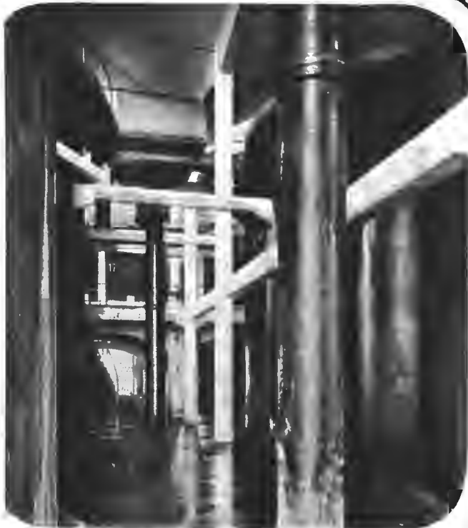
Гигантскіе баки для отстойки воды.
