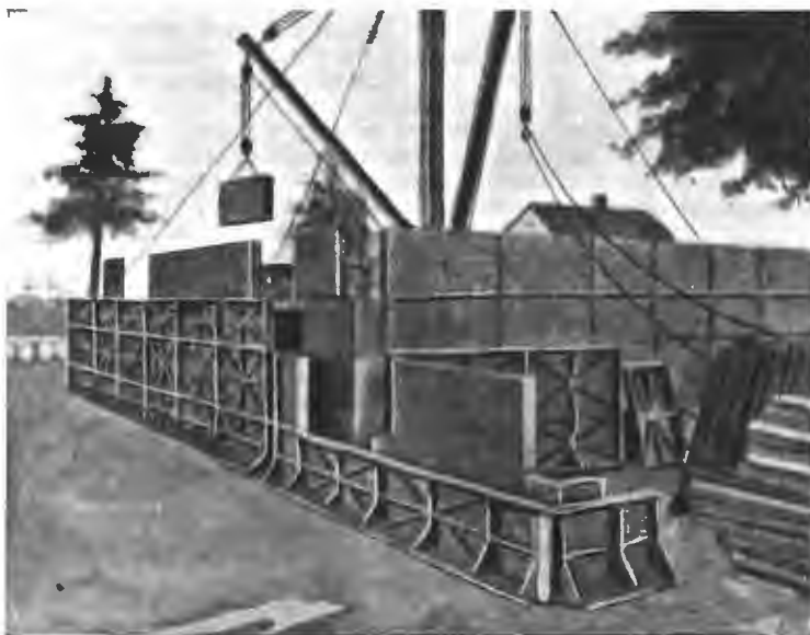
Рис. 2. Форма для дома Эдисона, составляемая изъ отдельныхъ частей.
