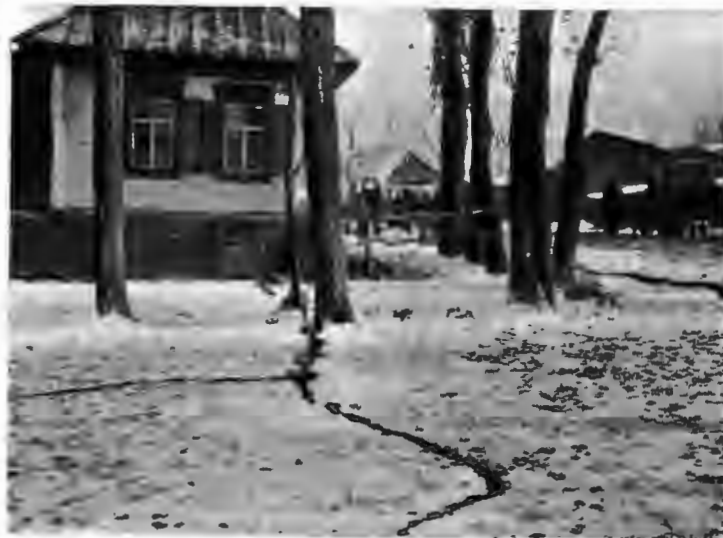
Трещины земли и дерево, расщепленное на части. Знакомъ X отмѣчено мѣсто расщепла дерева.
