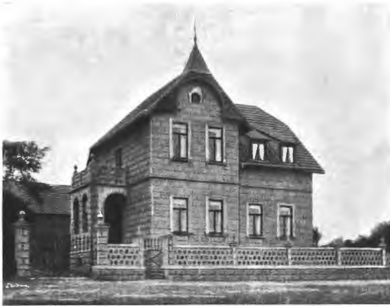
Домъ изъ пустотныхъ бетонныхъ камней (Курортъ Шмидебергъ).
