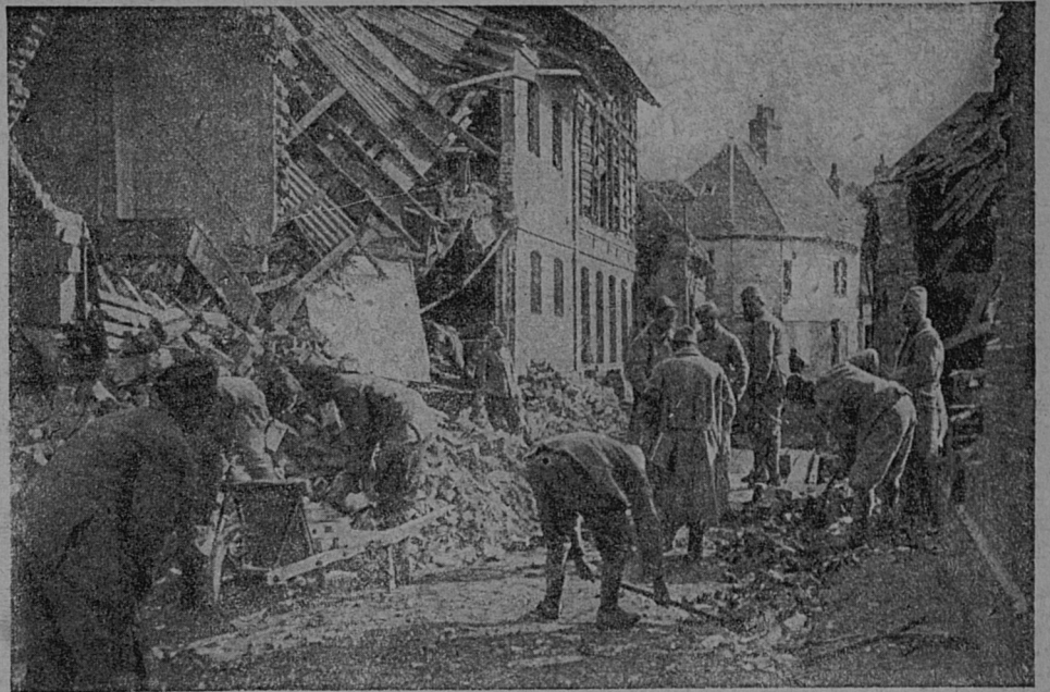
Французскія войска возстановляютъ улицы Нойона, разрушенныя немцами.
