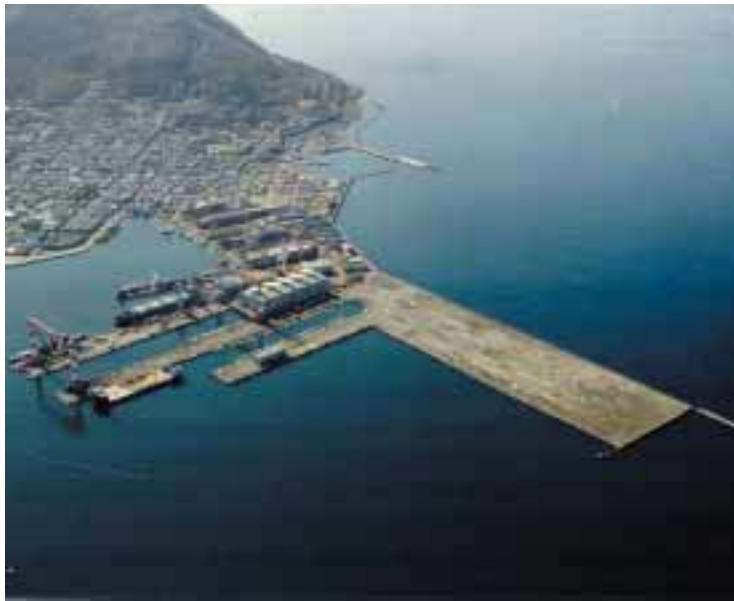
国際水産・海洋総合研究センターの建設が計画されている函館港弁天地区
