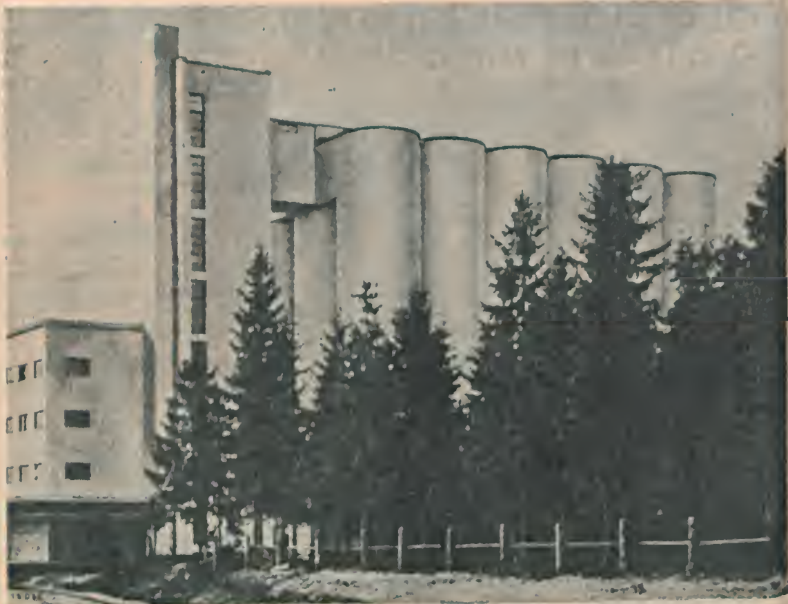
Silo de Jaaski, Finlândia. Equipamento mecânico da Fábrica Buhler, Uzwil, Suíça
