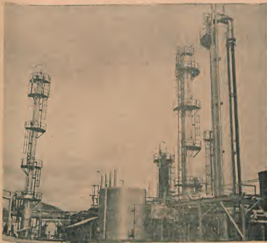
A fábrica de fertilizantes de Cubatão, ocupando uma área de 320.000 metros quadrados, tem capacidade para produzir diariamente 310 toneladas de calcitas e 31 toneladas de Sulfato de Amonio
