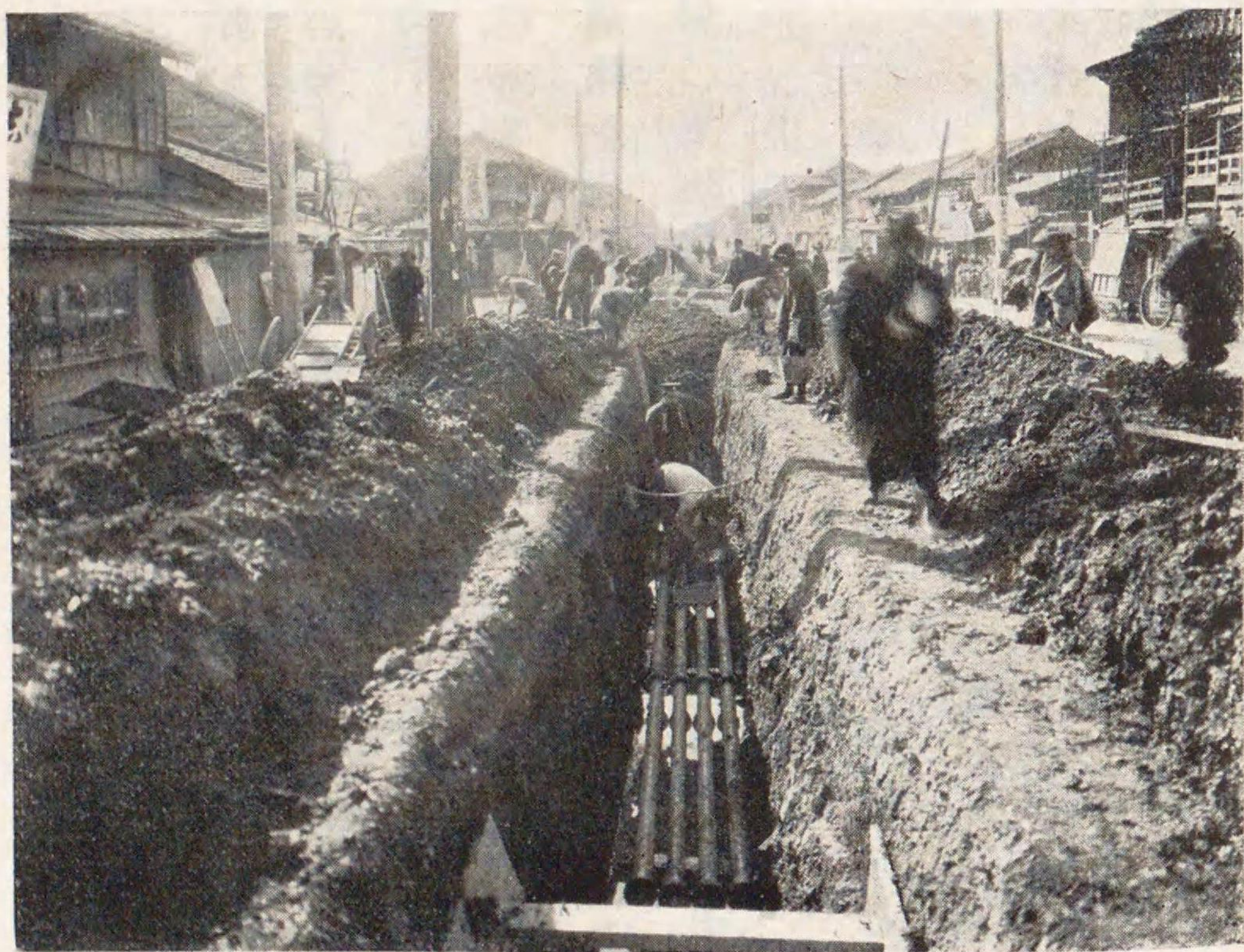
地下電話線の敷設に於ける作業の状況
