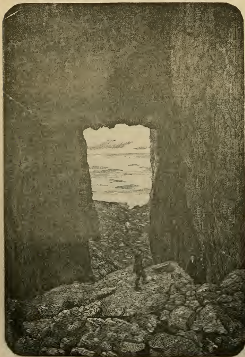
Der Tunnel des Torghatten. (Fig. 4.)
