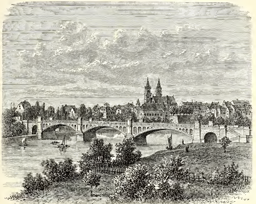
Nr. 384. Die neue Rheinbrücke in Basel.
