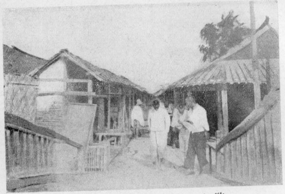
鎮市等二某區三第東啓
