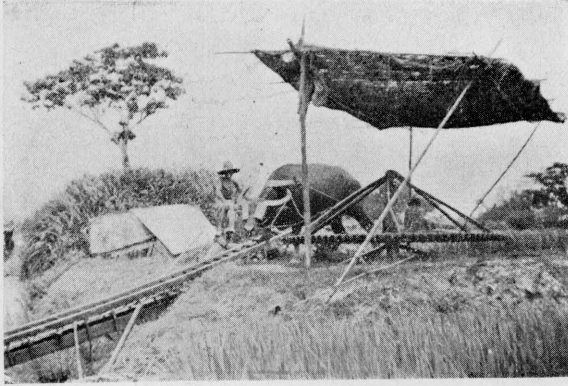
常熟鄉間之抽水牛車 現多改用機器 牛車已不多見
