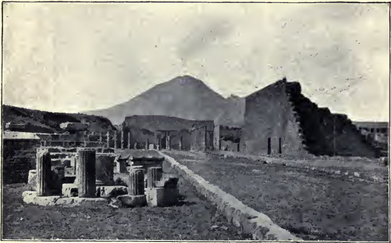
Fig. 67. Ansicht des Forum triangulare, gegen den Vesuv. — Links die Reste des dorischen Tempels, der Altäre und des Brunnenhauses vor demselben; rechts die Außenseite des großen Theaters.
