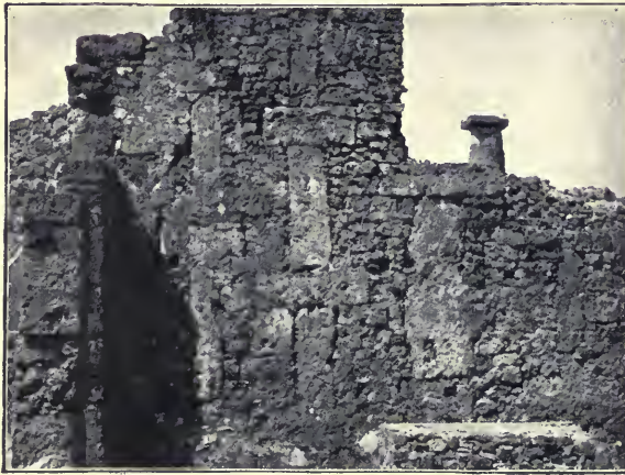
Fig. 9. Mauer mit Kalksteinfachwerk
