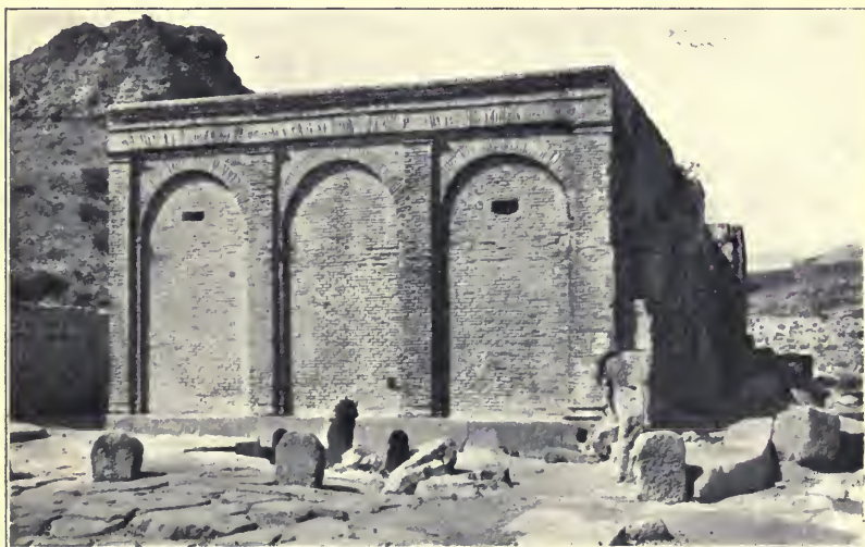
Fig. 117. Südfassade des Kastells der Wasserleitung.
