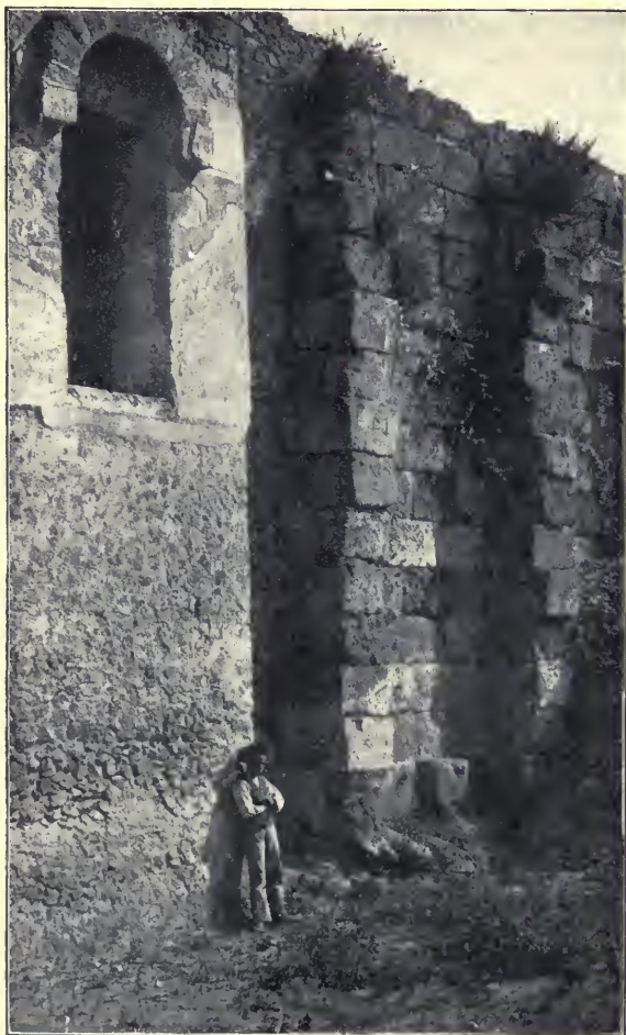
Fig. 122. Innenansicht der Stadtmauer nach Entfernung der Erdböschung, deren Höhe durch die Tür in dem Turm links bezeichnet ist.
