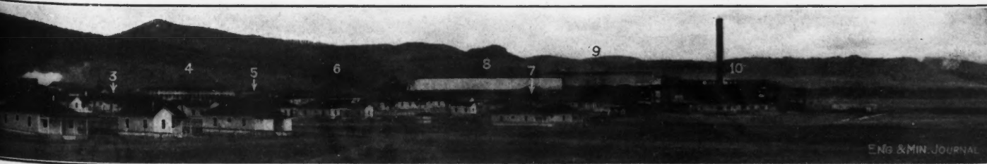
N. M., LOOKING EAST
