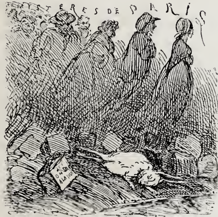
DÉMOLITIONS DE LA CITÉ. Ci-git le Lapin blanc ! (Ces démolisseurs ne respectent rien !)
