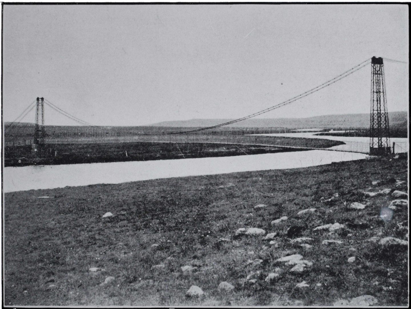
Puente "Bella Vista" sobre el Río Gallegos
