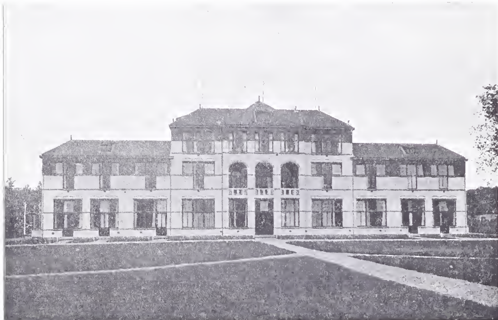
Sanatorium Hoog-Laren. Voorgevel. Architect: ED. CUYPERS.
