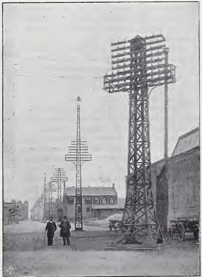
Licht- en geleidingsmasten voor den electrischen aanleg aan de Nieuwe Haven te Düsseldorf.
