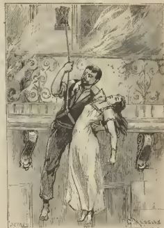
El descensor automático en función durante un incendio.
