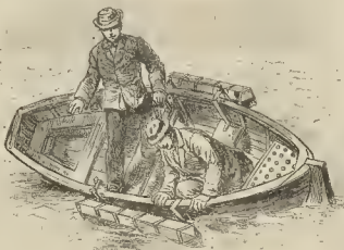
Fig. 2. - Aparato de seguridad del Sr. Dehnicke. Los tripulantes del bote haciendo inútilmente esfuerzos para que éste zozobre.
