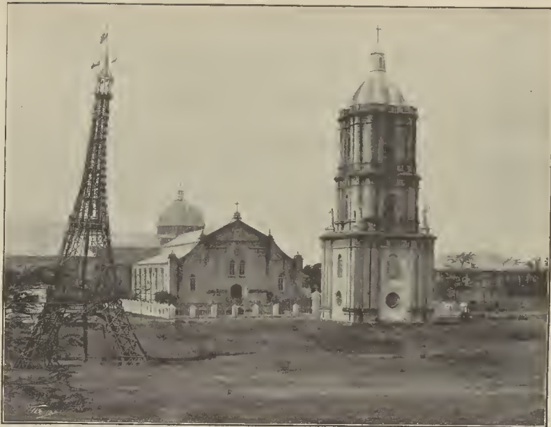
ISLAS FILIPINAS. - VISTA DE LA CATEDRAL DE JARO Y DE LA TORRE EIFFEL, CONSTRUIDA CON «CAN-YUAN» (BAMBU)
