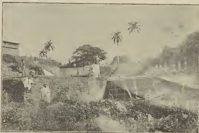
LA GUERRA DE CUBA. — Acueducto de Santiago de Cuba. La represa (de fotografía de D. A. Ferrer)
