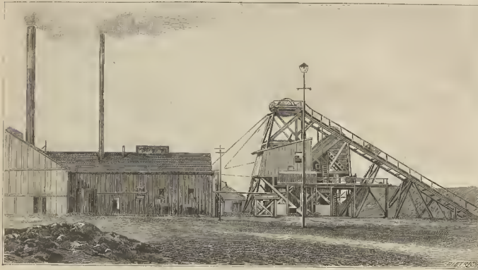
Fig. 1. - Instalaciones exteriores. A la izquierda la batería y a la derecha el apo del pozo inclinado (Mina de Gelderhais Estate)
