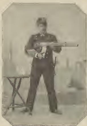
Fig. 2. - Carga del fusil con paquetes de cartuchos amovibles que se introducen por debajo de la mano derecha
