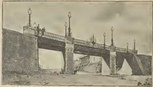
VIADUCTO DE LA BARRANQUILLA EN EL FERROCARRIL DEL NORTE DE GUATEMALA
