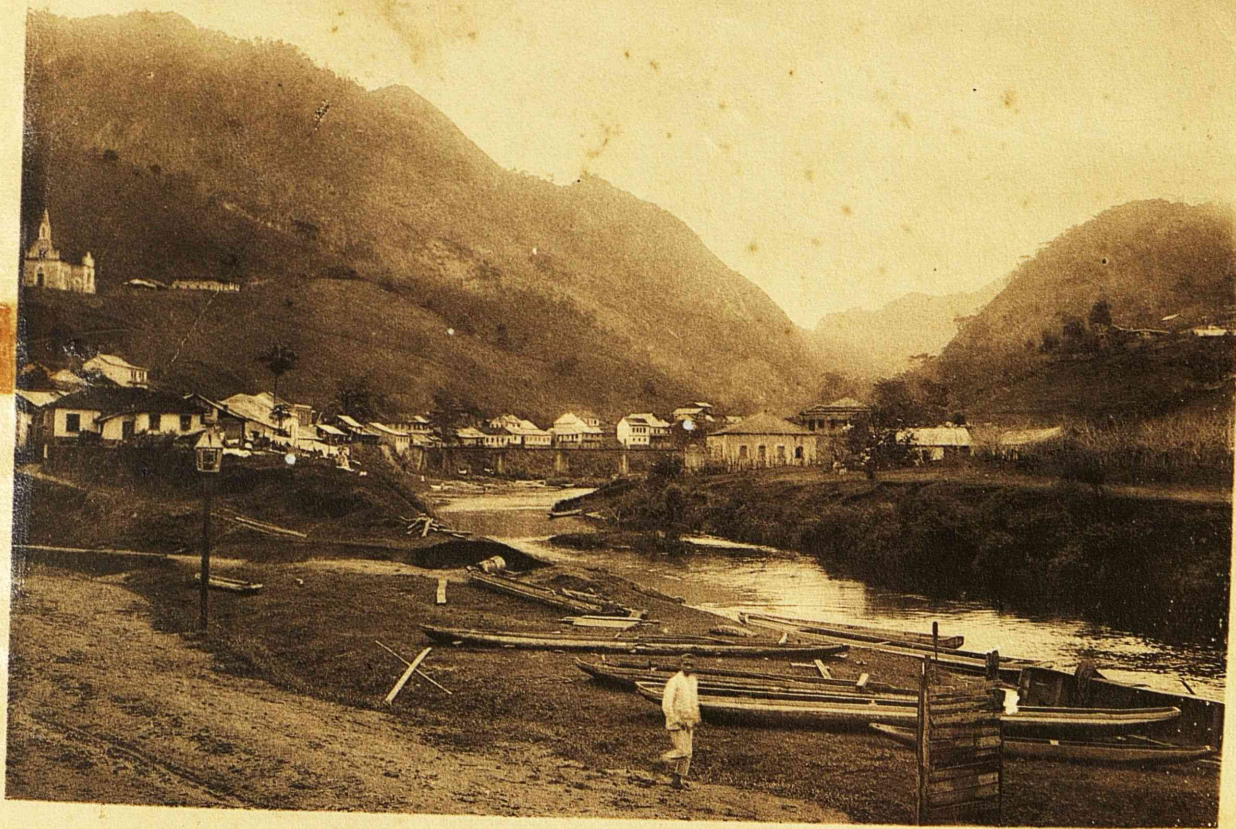
VISTA GERAL DA CACHOEIRA SANTA LEOPOLDINA
