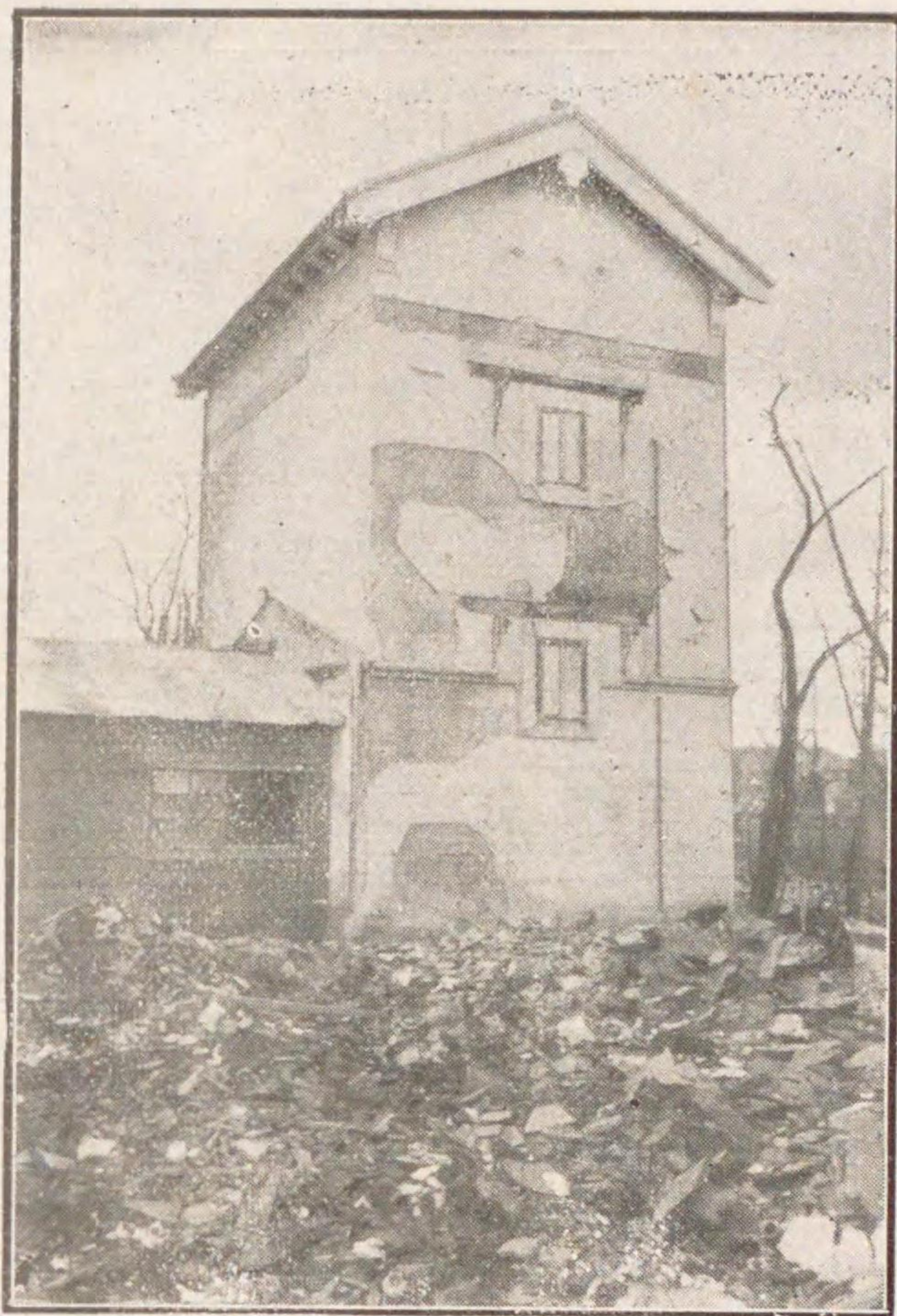
安全な全鉄筋コンクリート造
