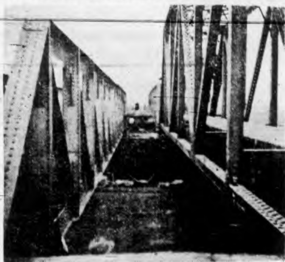
由漢口方面所攝之新舊橋梁
