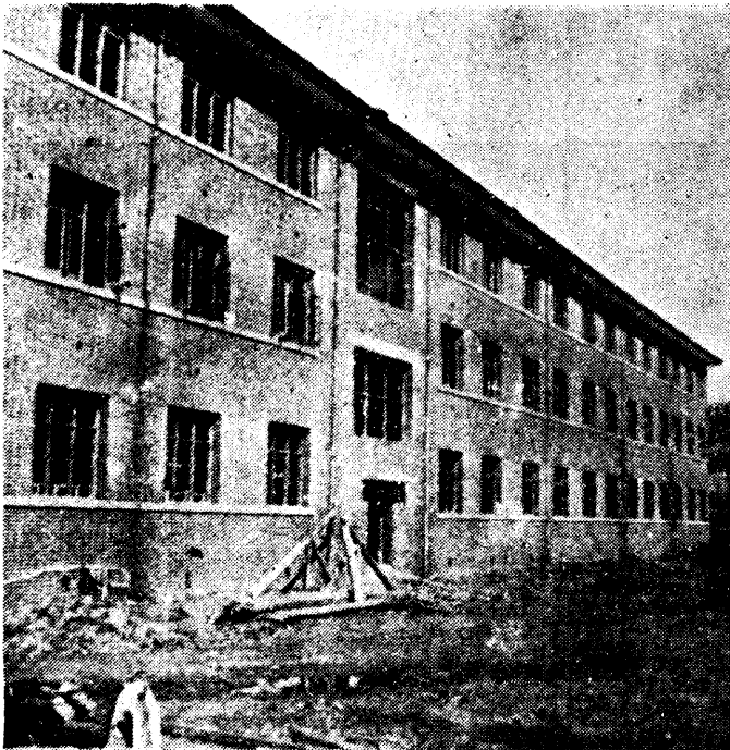
工振之16. 省立長沙醫院建築工程
