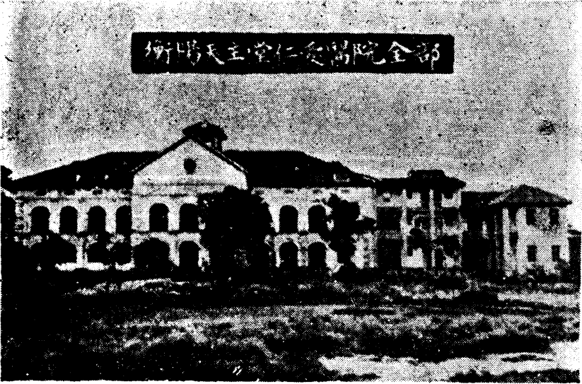
工振之19. 衡陽天主堂仁愛醫院修復之全貌
