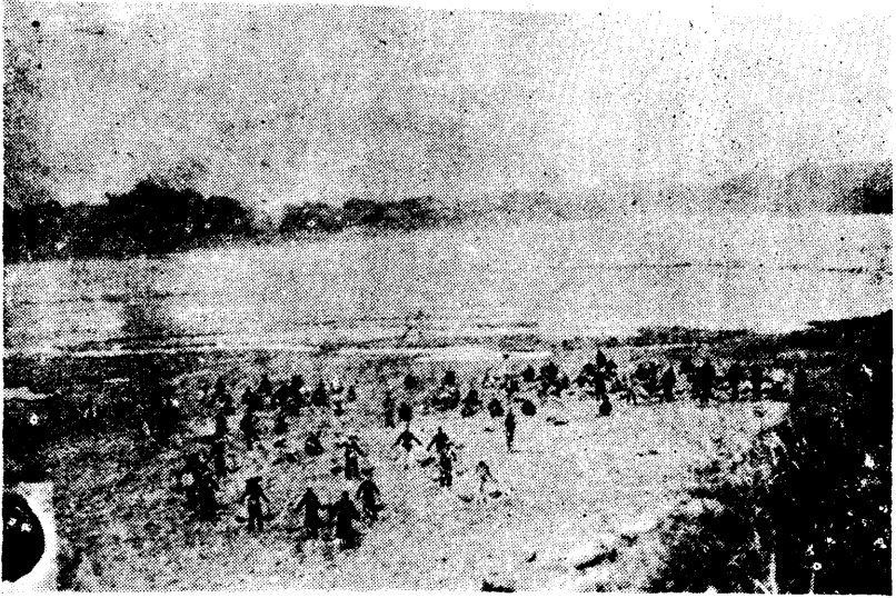
工振之1. 零東公路之鋪砂工程
