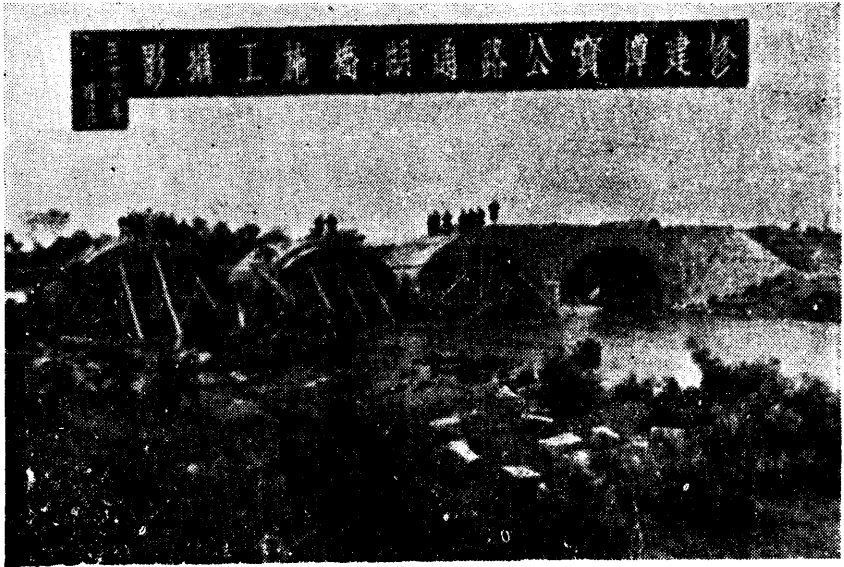
工振之5. 潭寶公路大橋工程
