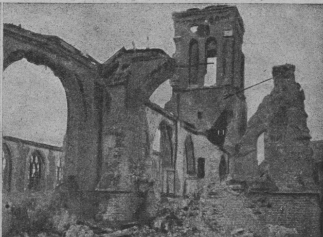
Церковь бельгiйскаго городка, почти совершенно разрушенная германскою бомбардировкою.
