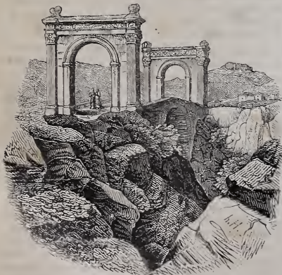
(Pont de Saint-Chamas.)
