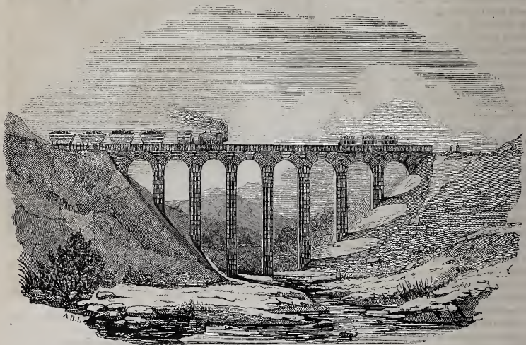
(Chemin de fer de Saint-Étienne à Lyon. — Arceaux du Voiron.)
