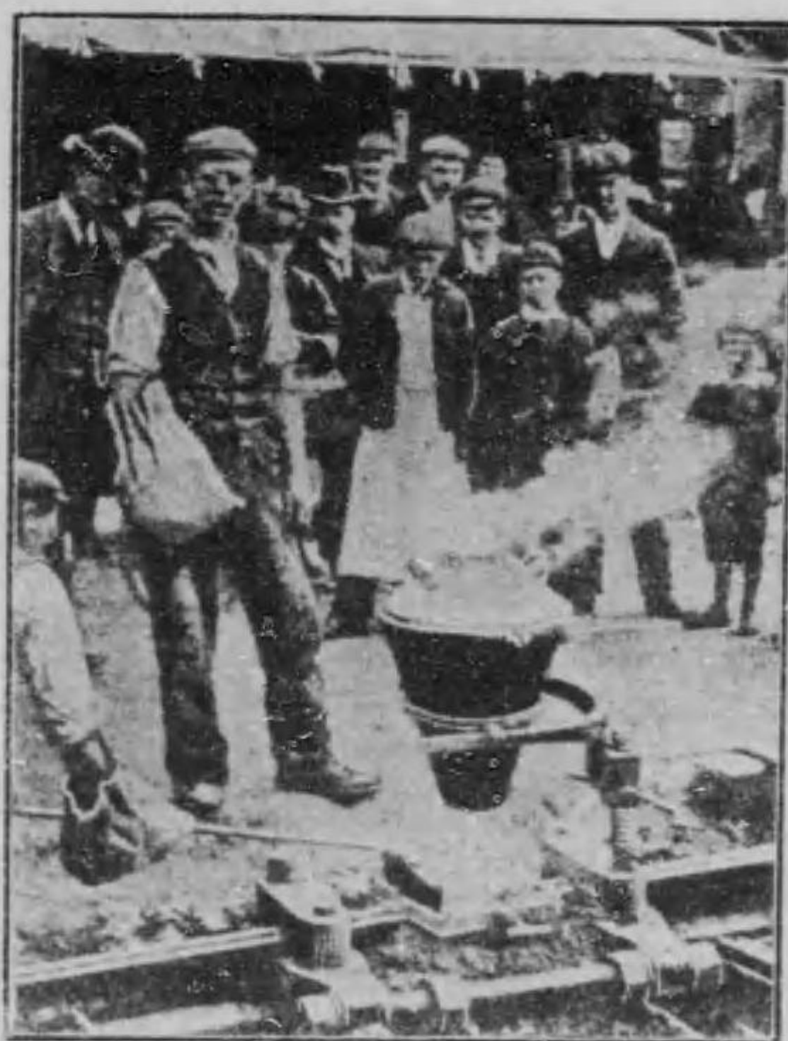
第九十五圖 テルミット 使用の有様 を示す
