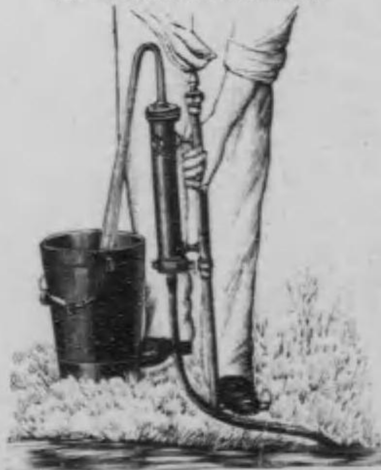
圖ノ用使(乙)器水濾式筒唧
