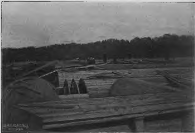
Видъ резервуара съ частью выложенныхъ сводовъ.
