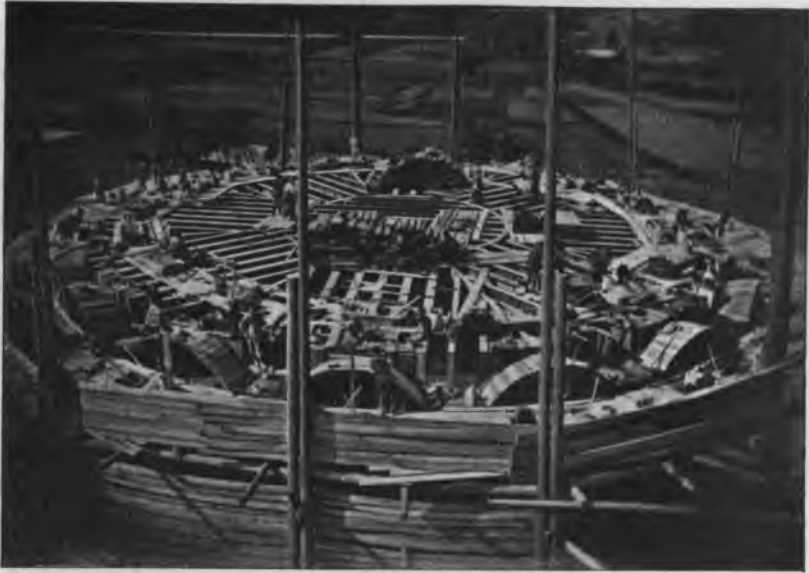
Кладка стѣнъ западной башни выше уровня подрезервуарныхъ балокъ.
