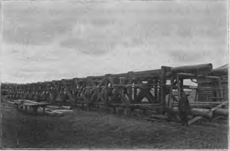
Сборка кѣтки для подъемной машины для подачи матеріаловъ при восточной башнѣ.
