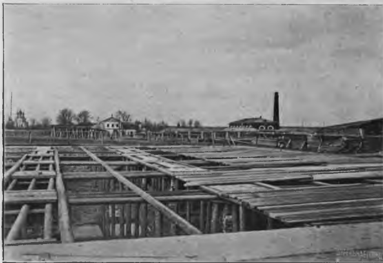
Устройство подмостей для установки кружалъ для кладки сводовъ.
