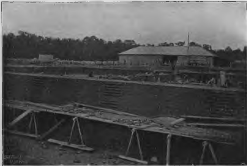
Кладка раздѣлительной стѣны между двумя отдѣленіями резервуара.
