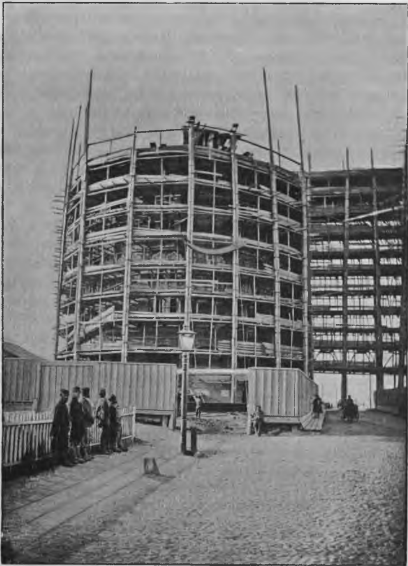
Подъемъ на западную башню частей желѣзнаго резервуара.
