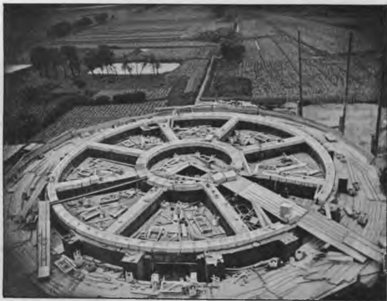
Окончаніе укладки прокладнаго ряда изъ тесанныхъ камней между четвертымъ и пятымъ этажами западной башней. Видъ съ лѣсовъ восточной башни.
