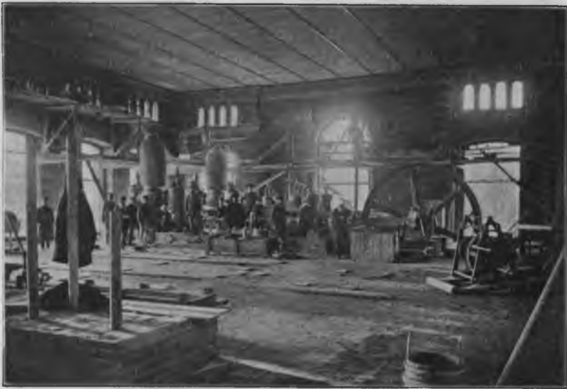
Сборка водоподъемной машины.
