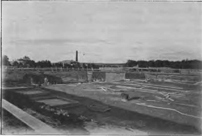
Кладка бетоннаго основанія.
