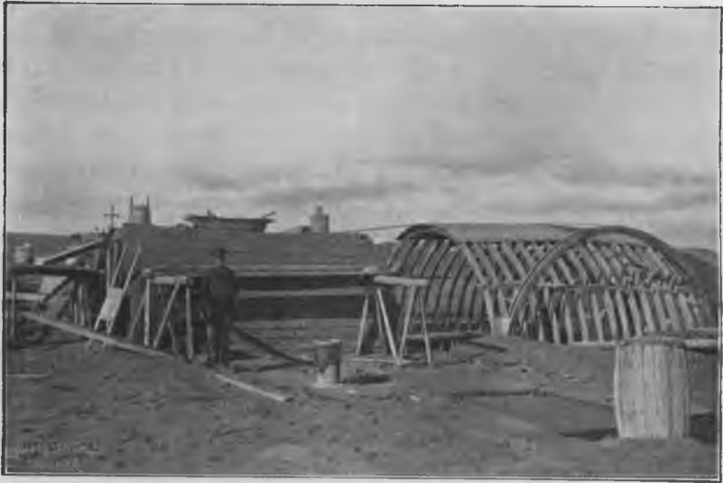
Кладка сводовъ вестибюля резервуара.
