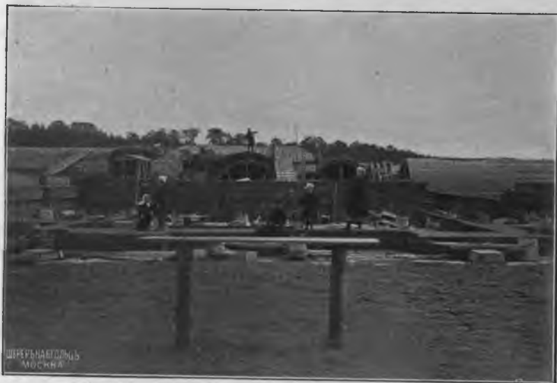
Кладка стѣнъ вестибюля и сводовъ резервуара.
