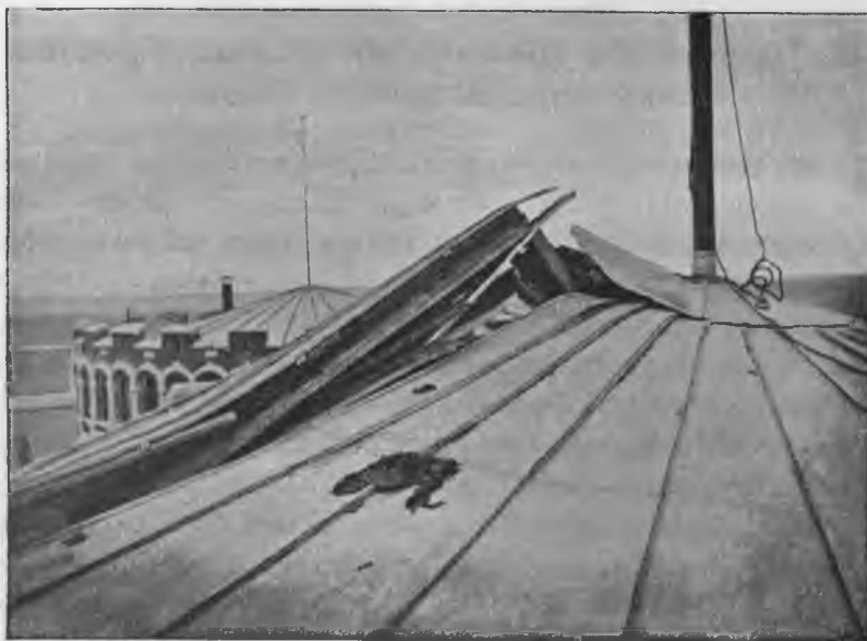
Разрушеніе части крыши восточной башни выкидомъ воды.
