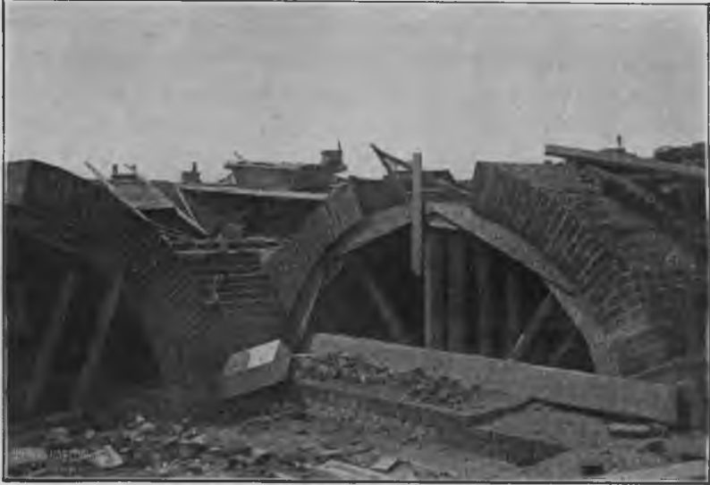
Кладка ключа свода.
