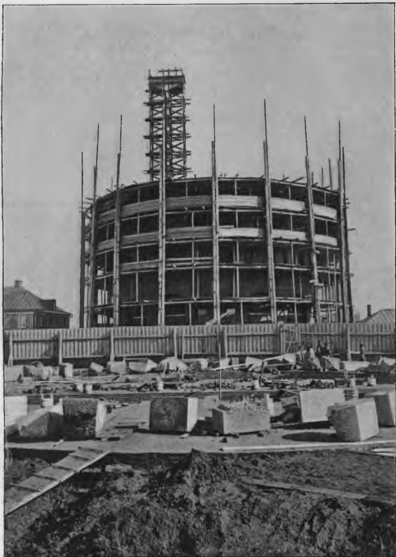
Видъ четырехъ этажей восточной башни и кладка гранитнаго цоколя западной башни.
