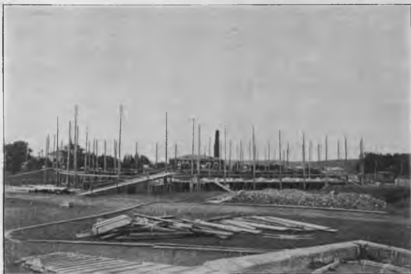
Начало кладки стѣнъ зданія поверхъ земли.
