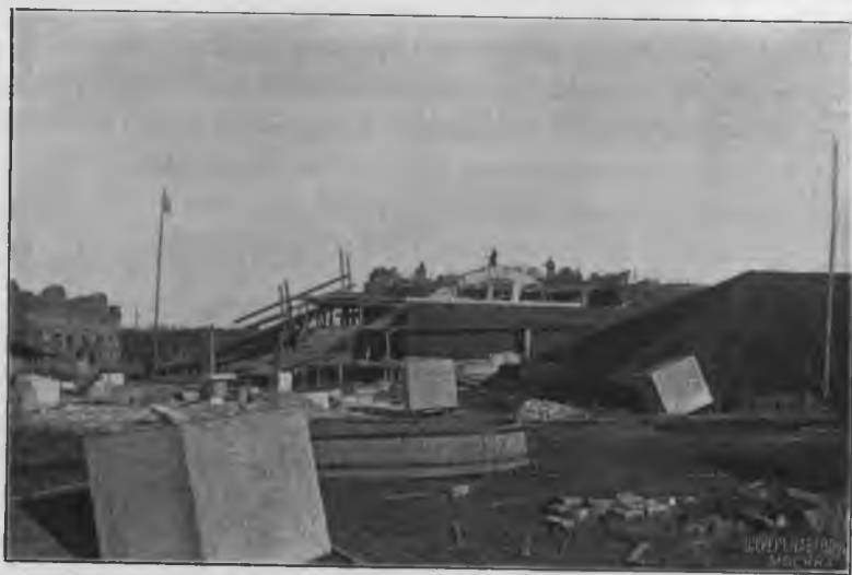
Положеніе работъ по постройкѣ резервуара предъ закрытіемъ ихъ на зиму.
