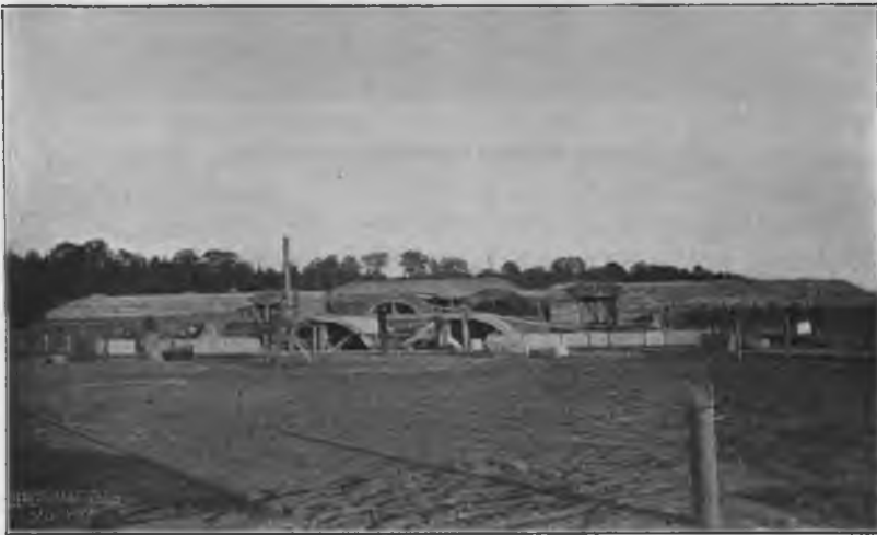
Видъ законченной кладки сводовъ резервуара.
