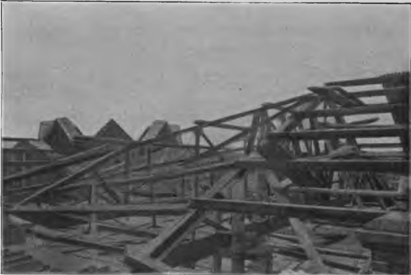
Постановка на зданіи желѣзныхъ стропиль.
