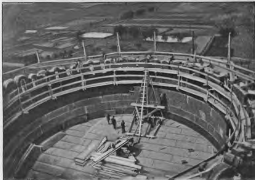
Сборка и клѣпка стѣнокъ резервуара восточной башни.
