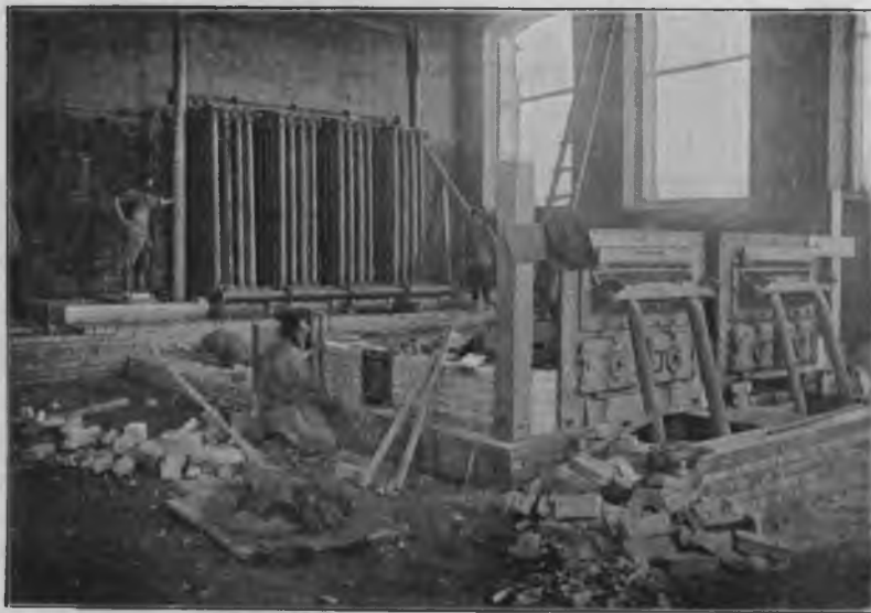
Установка паровыхъ котловъ и экономайзера.
