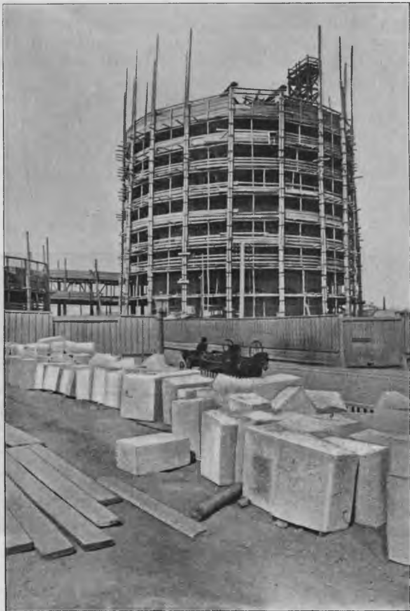
Видъ восточной башни, доведенной до уровня днища резервуара.
