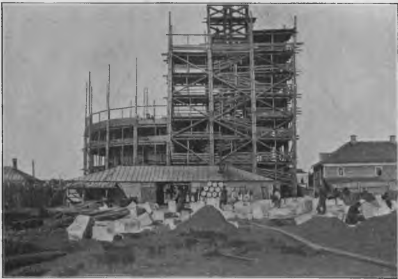
Начало кладки четвертаго этажа восточной башни.
