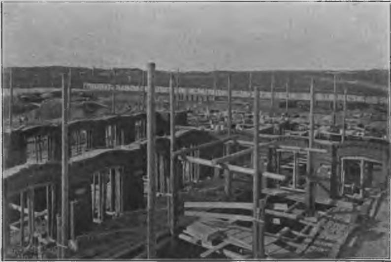
Окончание кладки оконных перемычек.
