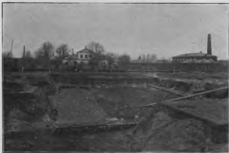
Начало кладки фундаментовъ.
