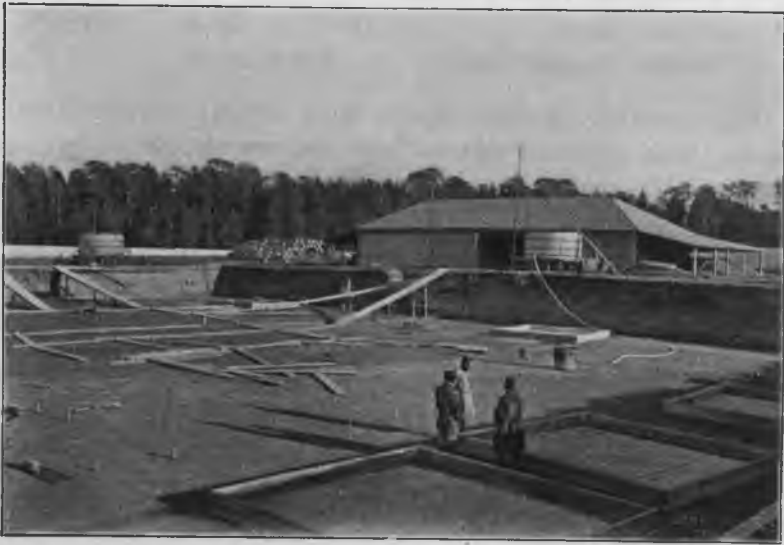
Укладка бетоннаго основанія.
