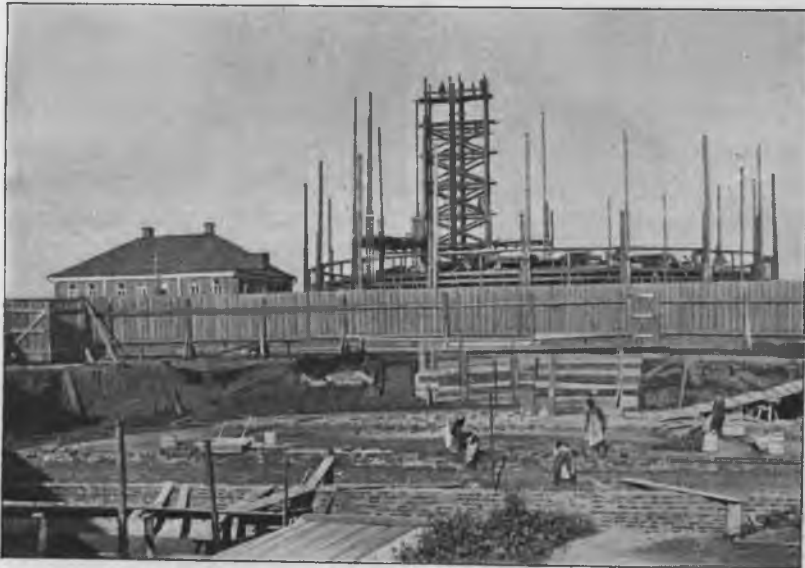
Кладка фундамента западной башни. Позади видна клетка подъемника и леса при восточной башнѣ.
