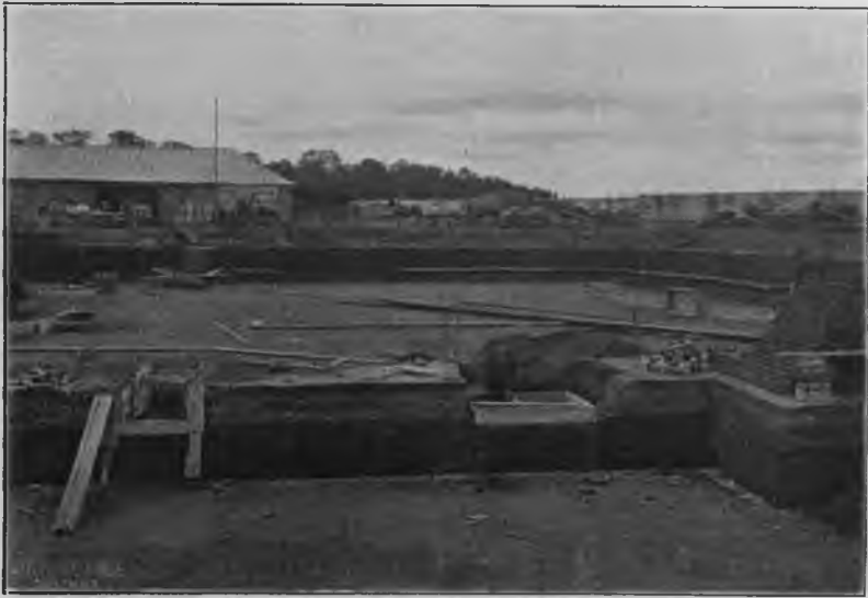
Кладка кирпичныхъ стѣнъ резервуара.
