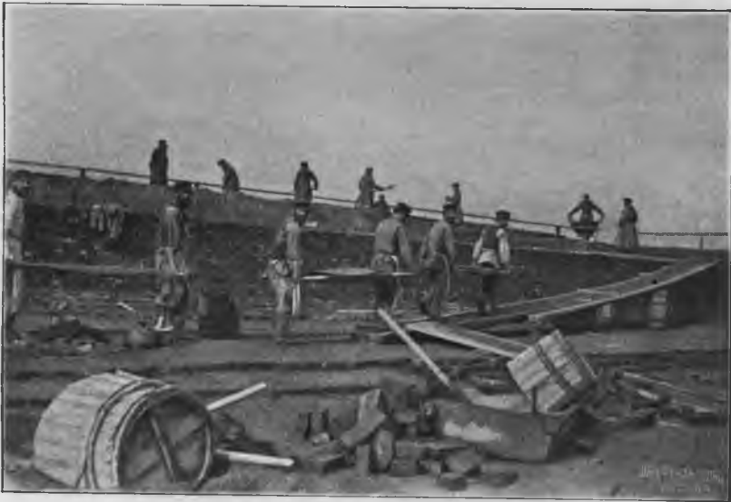
Окончаніе кладки основанія резервуара.
