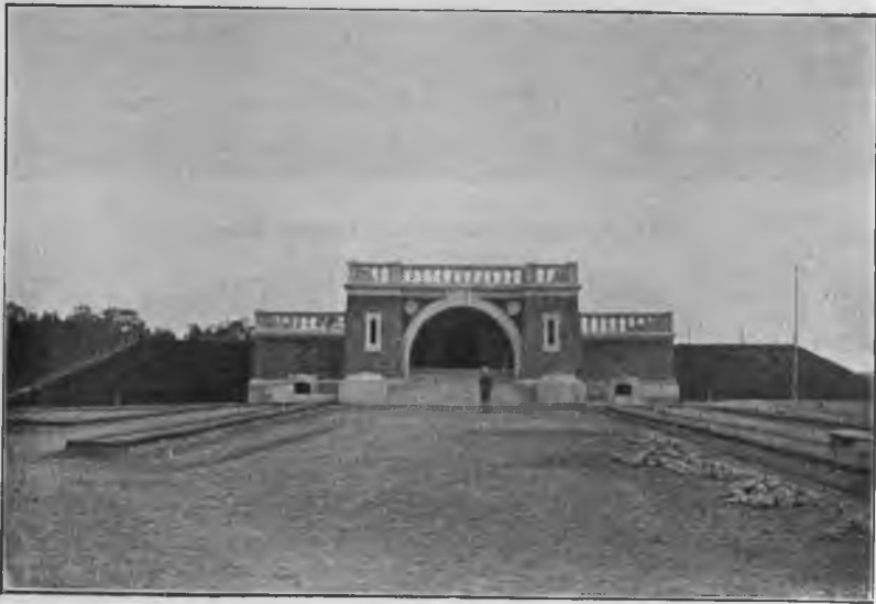
Видъ законченной постройки резервуара.
