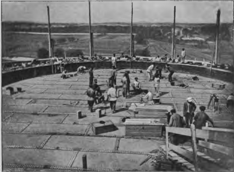
Клѣпка днища резервуара восточной башни.
