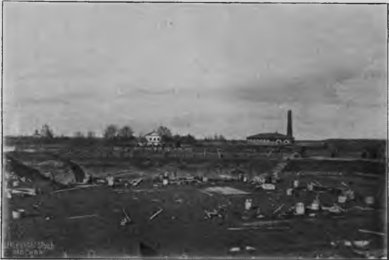
Общій видъ работъ по постройкѣ резервуара.
