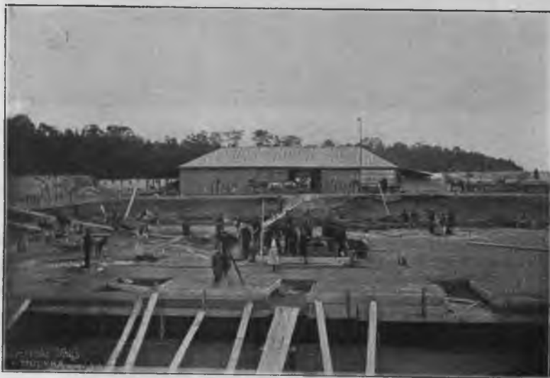
Окончаніе укладки бетоннаго основанія.
