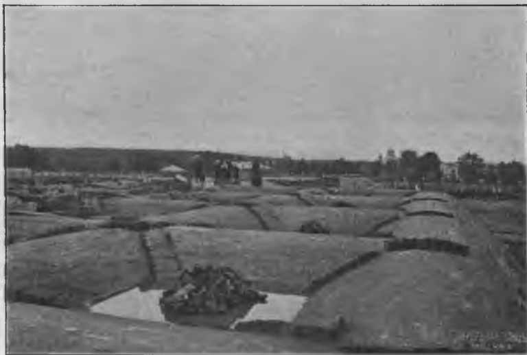
Видъ поверхности сводовъ резервуара.
