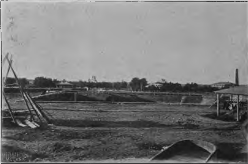
Котлованъ для постройки резервуара.
