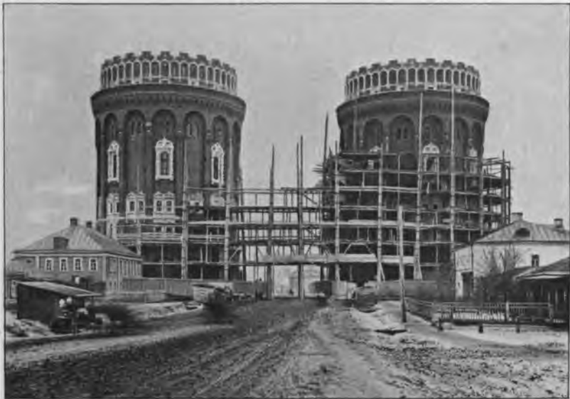
Видъ башенъ съ стѣврной стороны во время начала разборки лѣсовъ западной башни. Подъемная машина уже разобрана.
