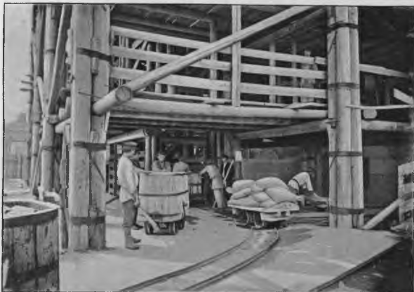
Подвозъ по рельсовому пути матеріаловъ къ подъемной машинѣ для подачи ихъ на башни.
