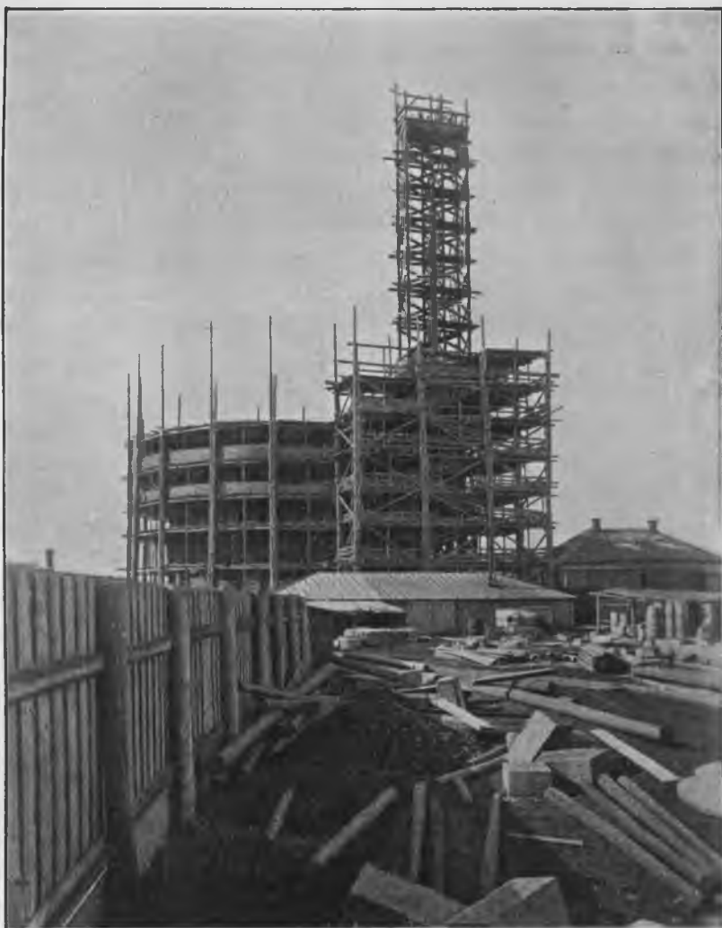
Выложено четыре этажа восточной башни и постановлена вся клѣтка подъемной машины.
