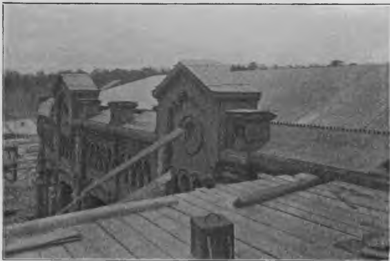
Покрытіе стропиль волнистымъ желѣзомъ.
