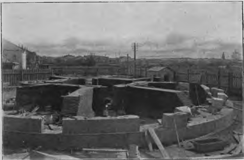
Кладка гранитнаго цоколя восточной башни.
