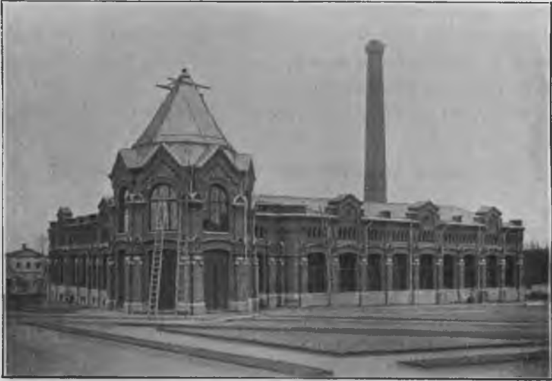
Видъ законченнаго водоподъемнаго зданія.
