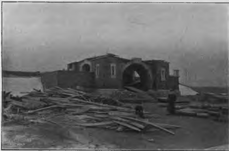
Видъ резервуара весною при началіи работъ.
