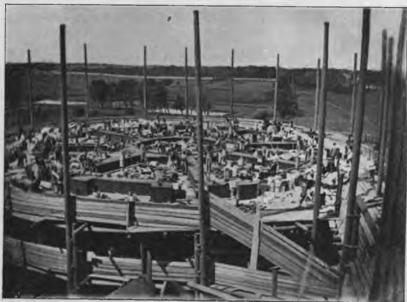
Кладка стѣнъ западной башни,—видъ съ лѣсовъ восточной башни.
