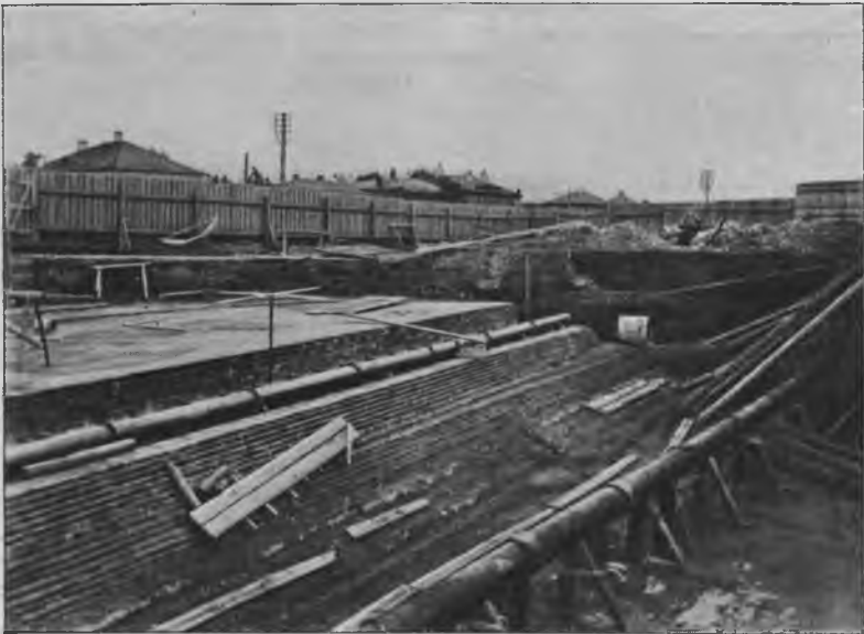
Отведеніе 16" чугуннаго Дельвиговскаго водовода, проходящаго черезъ площадь основанія западной башни, въ ея фундаментную галлерей.
