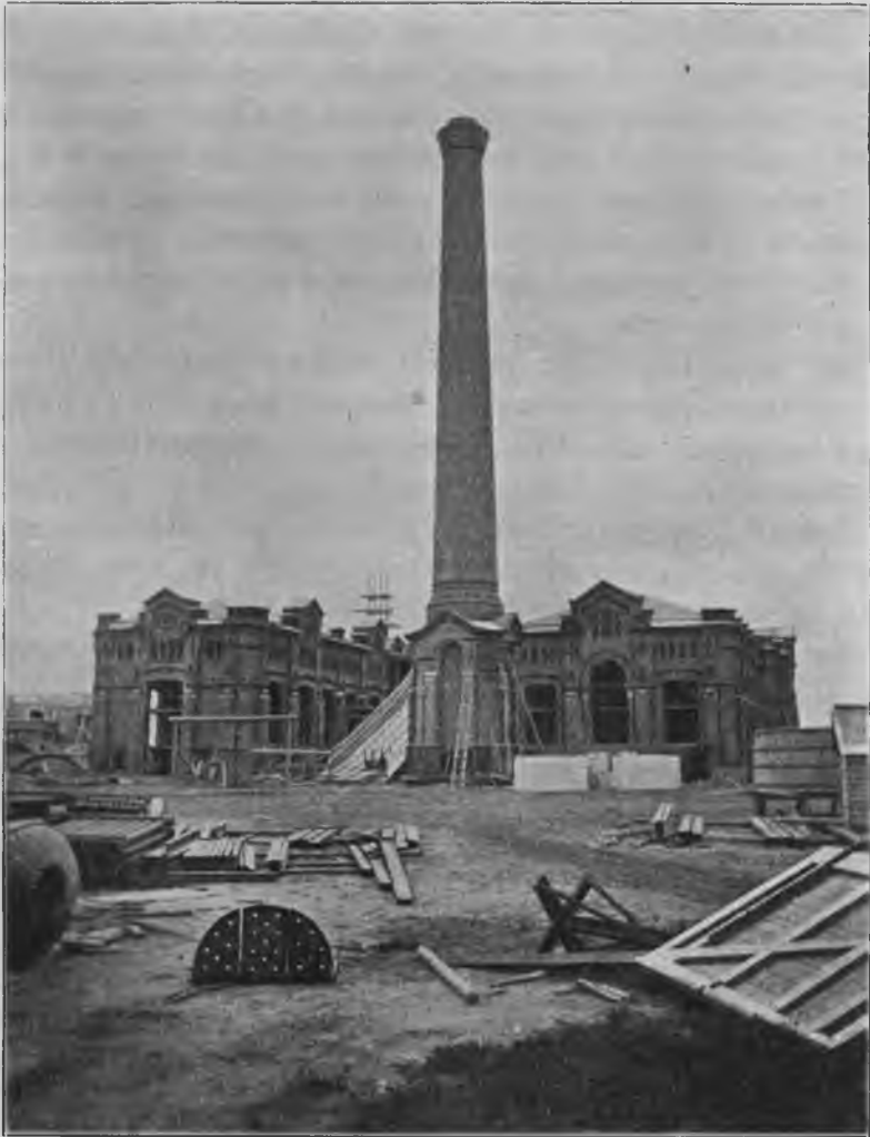
Видъ зданія и дымовой трубы съ восточной стороны.
