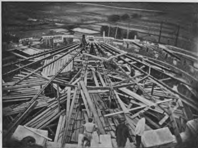
Сборка стропиль на восточной башнѣ.
