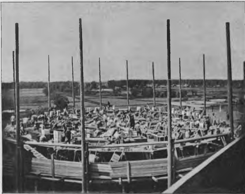
Укладка прокладнаго ряда изъ тесанныхъ камней между четвертымъ и пятымъ этажами западной башни.
