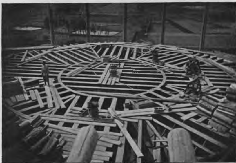
Сборка подрезервуарныхъ балокъ на восточной башнѣ.
