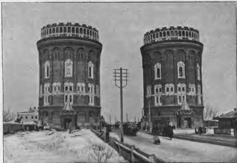
Видъ Крестовскихъ водонапорныхъ башенъ съ юга по окончаніи разборки лѣсовъ.
