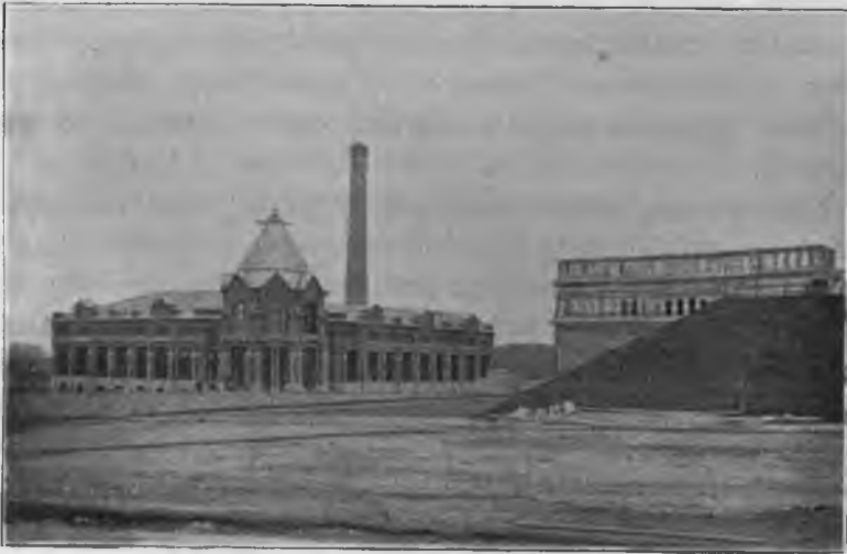
Видъ зданія въ связи съ резервуаромъ.
