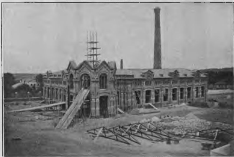
Видъ работъ съ юго-восточной стороны.
