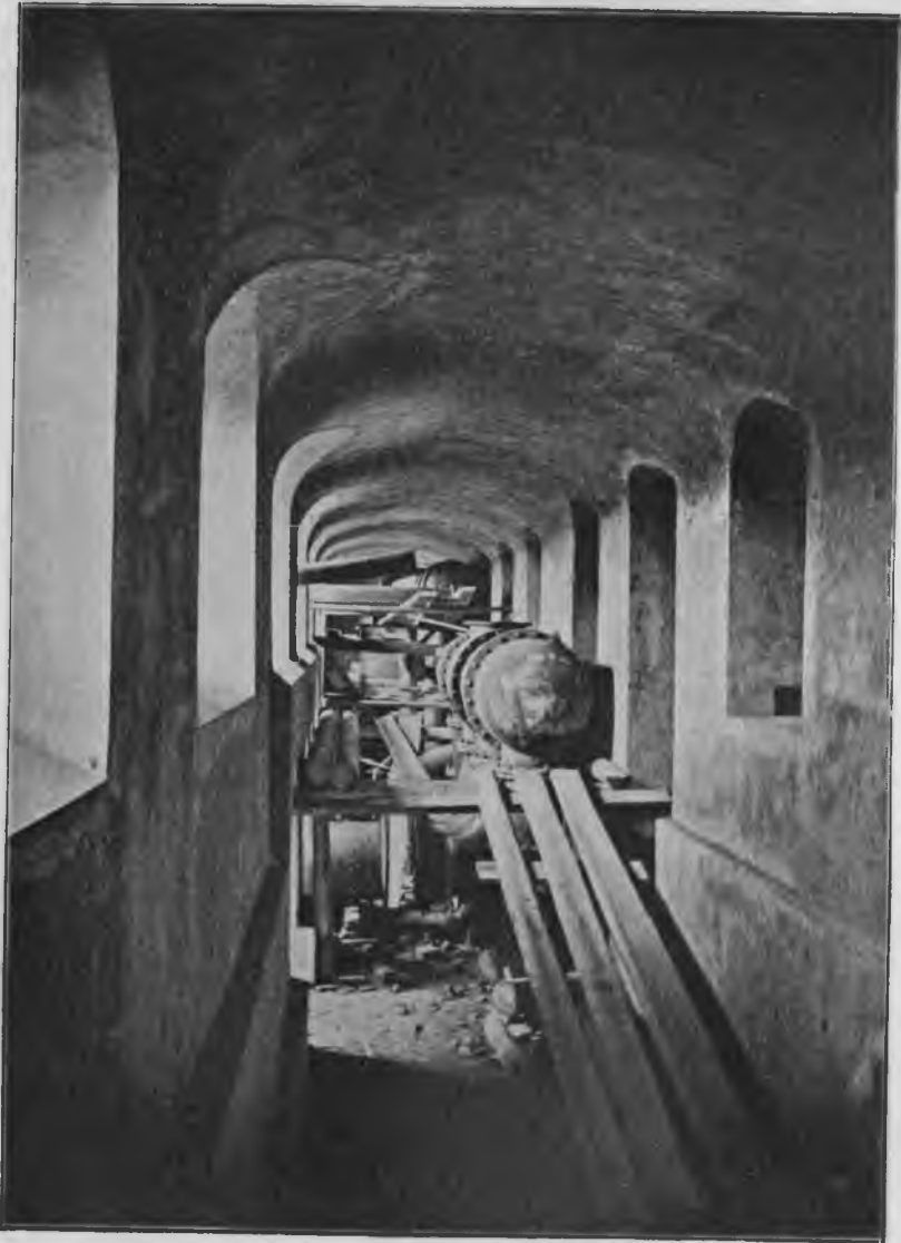
Галерея подвального этажа зданія.
