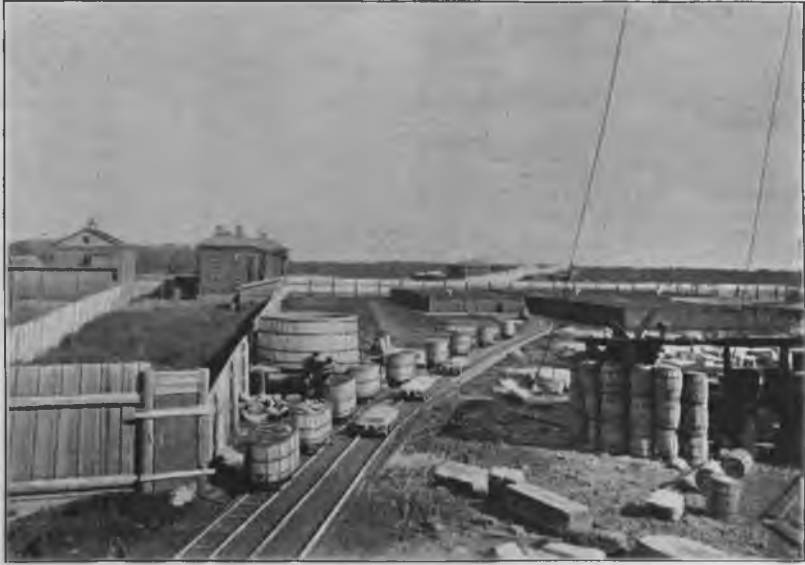
Складъ кирпича, подвозка его къ мѣсту работъ и вымачиваніе его на пути въ вагонетахъ-резервуарахъ.
