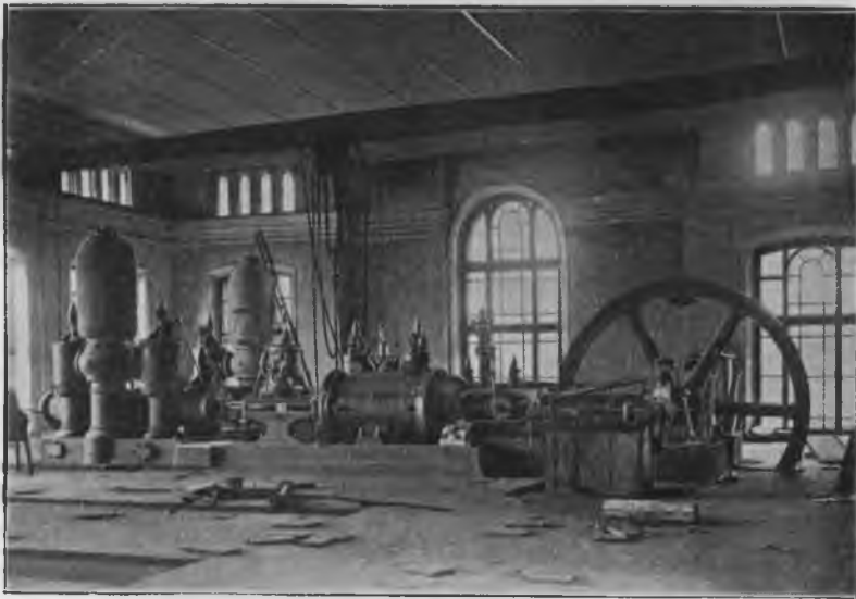
Видъ установленной водоподъемной машины.
