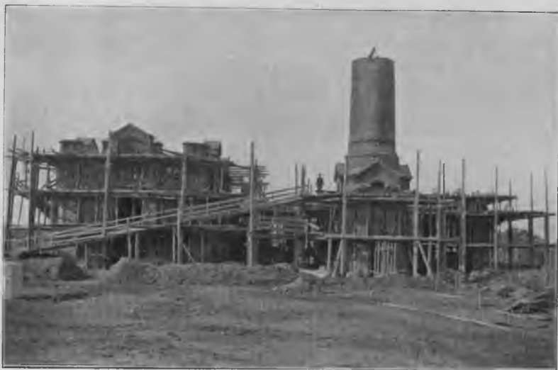
Кладка дымовой трубы.
