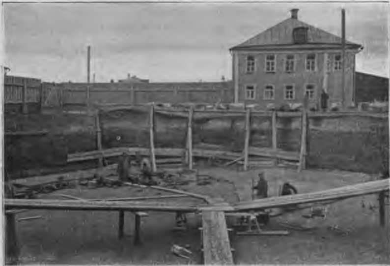
Окончаніе бетонной и начало кирпичной кладки фундамента восточной башни.
