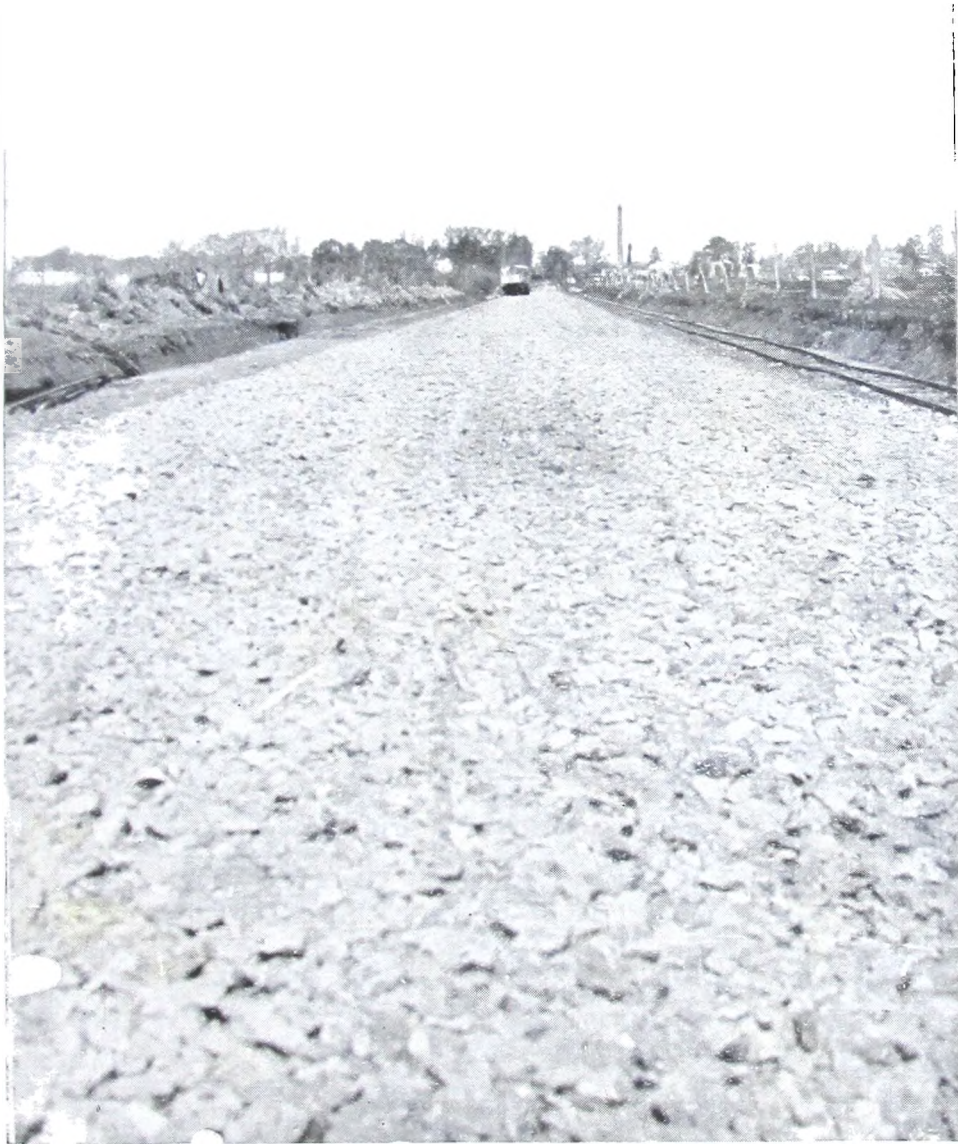
Zona Capital «B». — Vista del macadán en construcción en el camino de Bella Vista a Campo de Mayo
