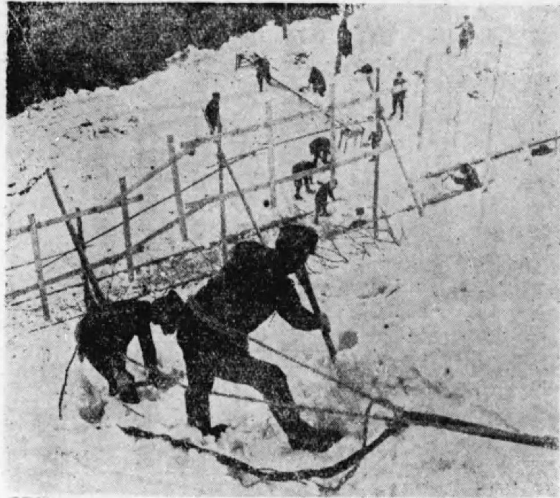
第18圖 積雪卸し作業(命綱使用)
