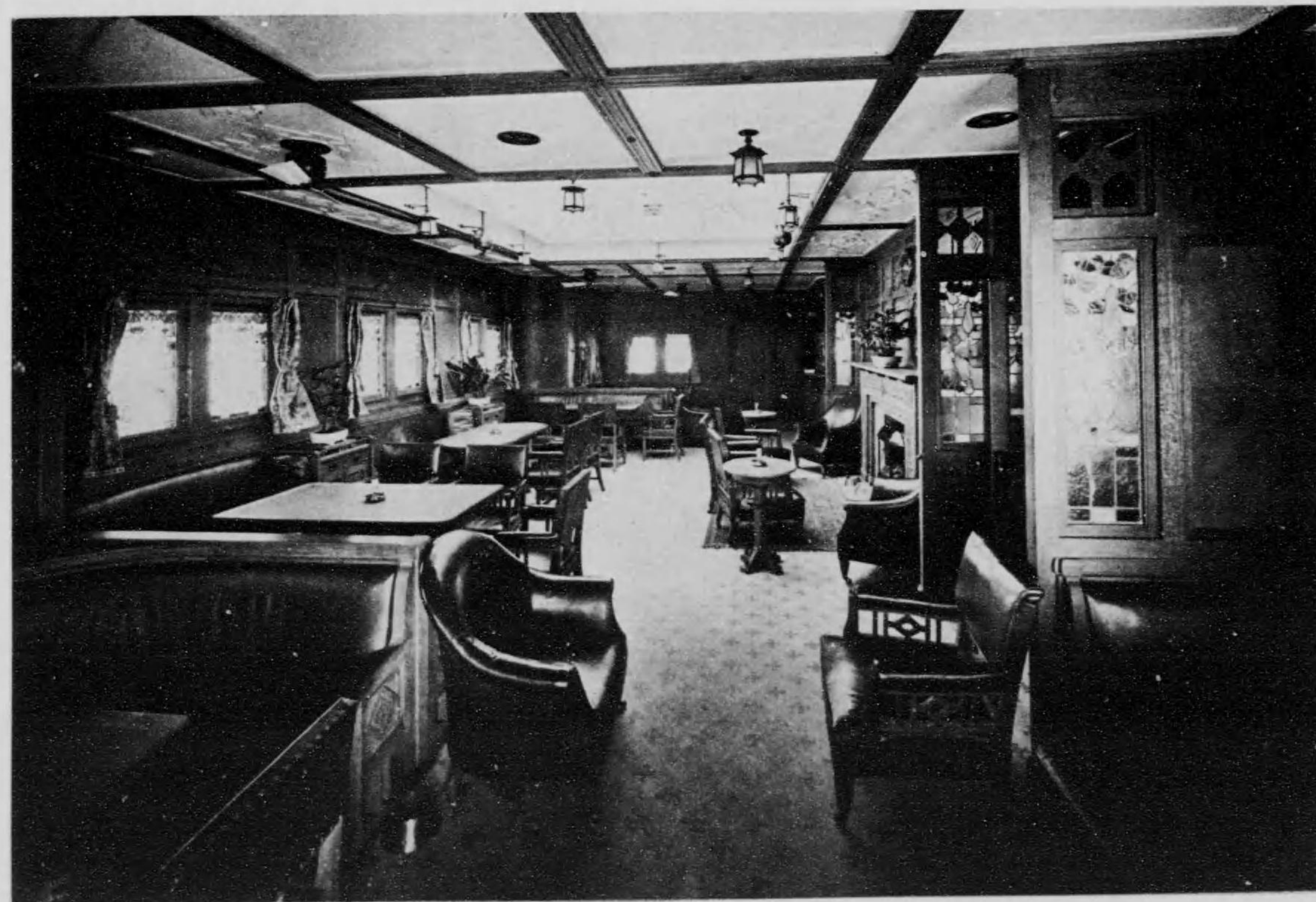
伏見丸一等喫煙室
