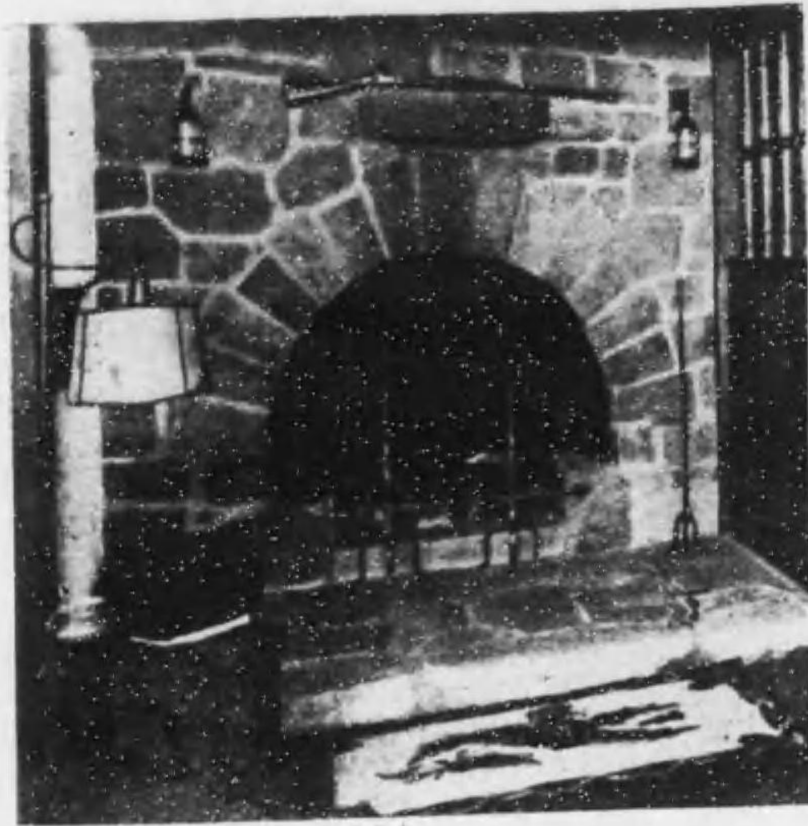
入込に設けた暖爐
