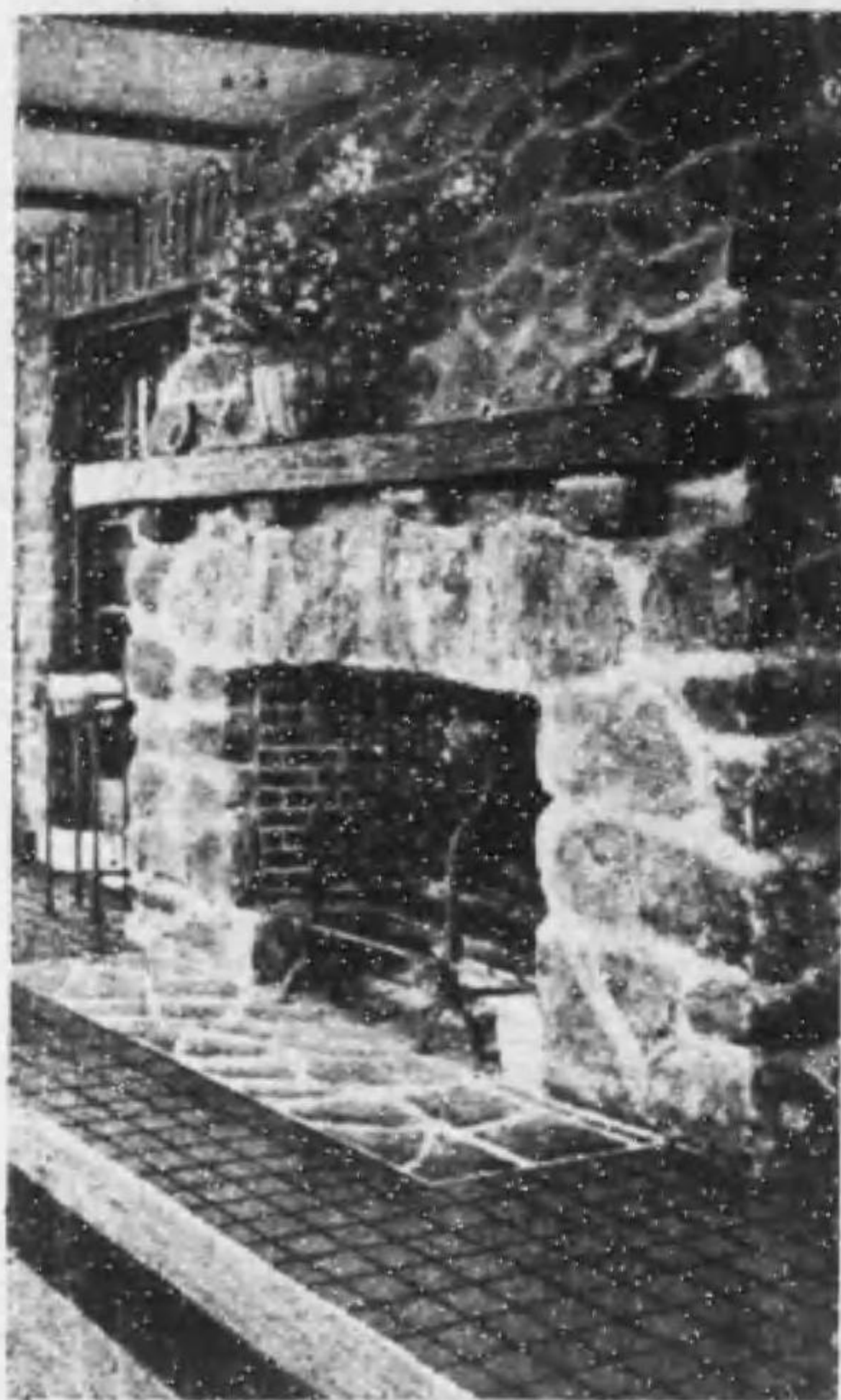
粗石積の面白い煖爐ではないか。 簡素なマンテル・ピースの意匠振 りにも注視していただきたい。
