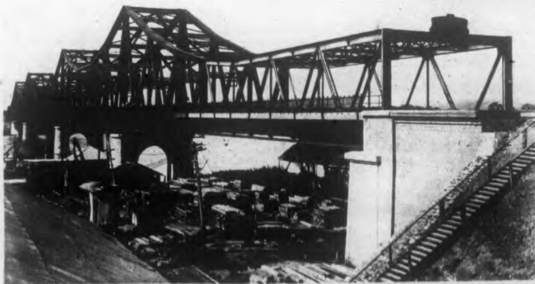
最近建築之柏蘭福鐵橋
