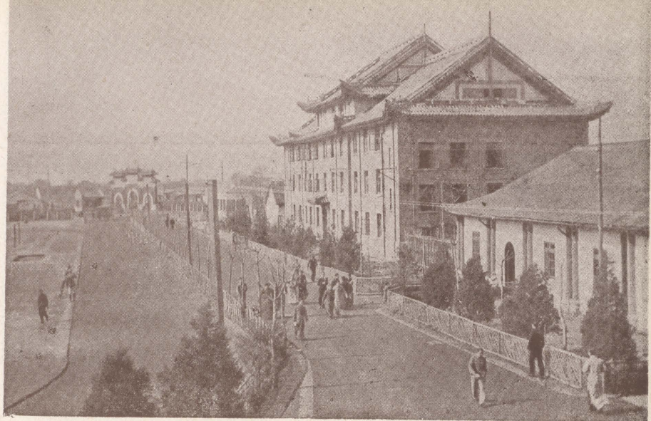
建築完成時校舍
