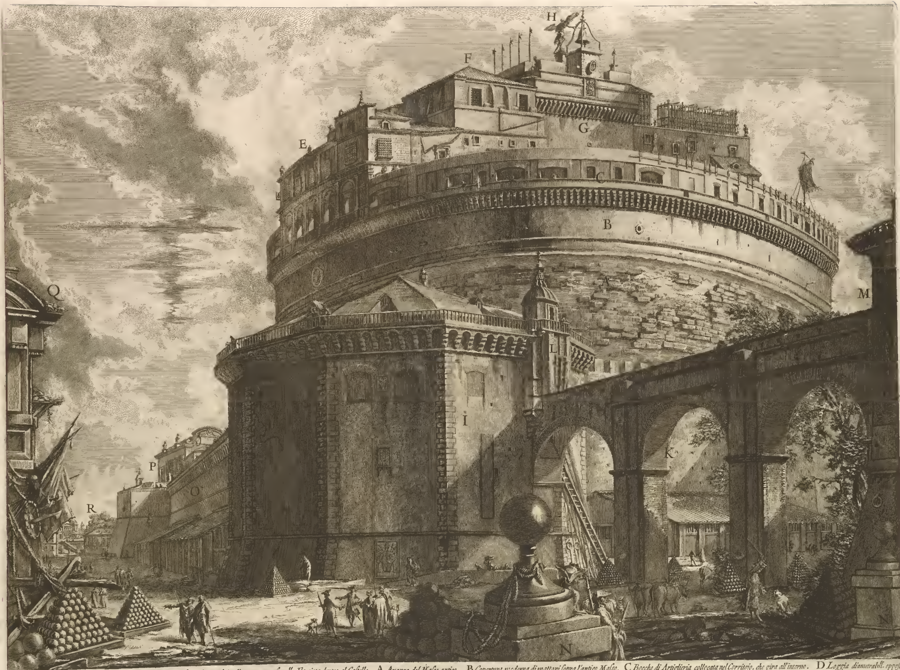
VEDUTA del Mausoleo d'Elia Adriano (ora chiamato Castello S. Angelo) nella parte opposta alla Facciata dentro al Castello. A Avanzo del Mafio antico. B Copertura moderna di mattoni sopra l'antico Mafio. C Boche di Artiglieria collocata nel Corritio, che gira all'intorno. D Loggia dianuvabili, opposta alla Facciata del Mausoleo. E Carceri per le persone riguardevoli. F Archivio. G Mafichietto. H Angelo di metallo. I Baluardi fatti piantare dal Pontefice Alessandro VI. K Corritio fabbricato pavim per ordine d'Urbano VIII. Questo Corritio è sostenuto da gran numero d'Archi, e dal Palazzo Vaticano conduce sino dentro al Mafichio. L Ponte levatore del Corritio. M Polveriera. N Cordona, la quale porta sopra i Torrioni, e sopra le Mura del principale Racinto del Castello. O Racinto di Mura, e Baluardi, che circonda il Mafichio. P Armeria. Q Abitazione per gli Uffiziali, e Soldati. R Altra Polveriera.
