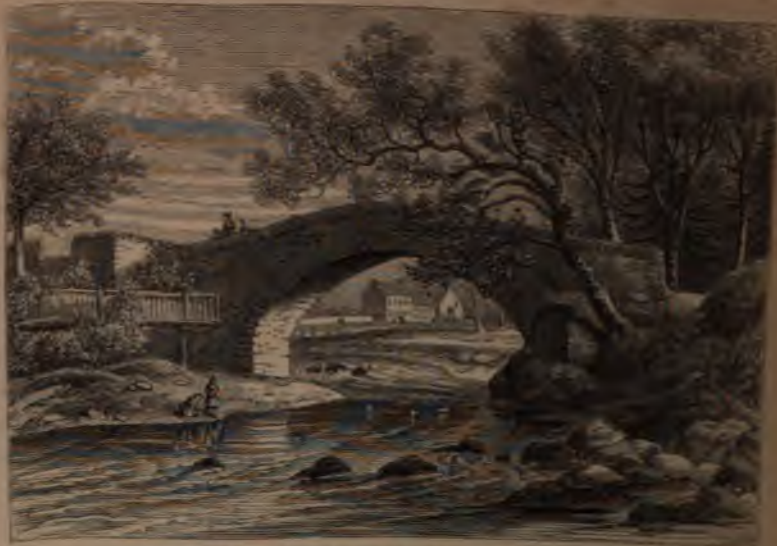
Fig. 52.—Old Bridge, Innerleithen.
