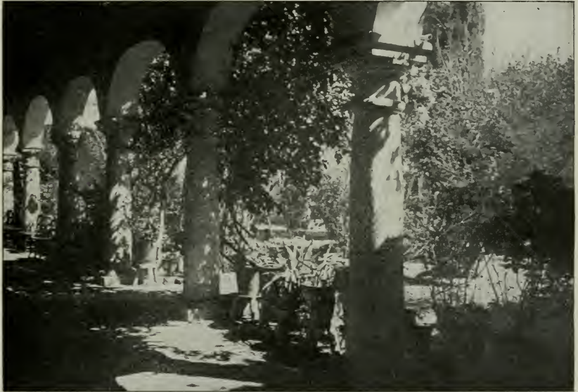
PATIO OF HACIENDA, AT MITLA.
