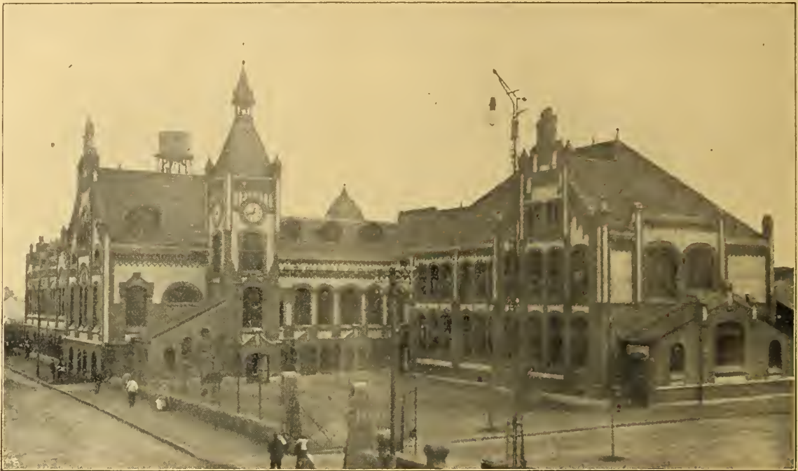
Fig. 1. Ansicht des Gebäudes.
