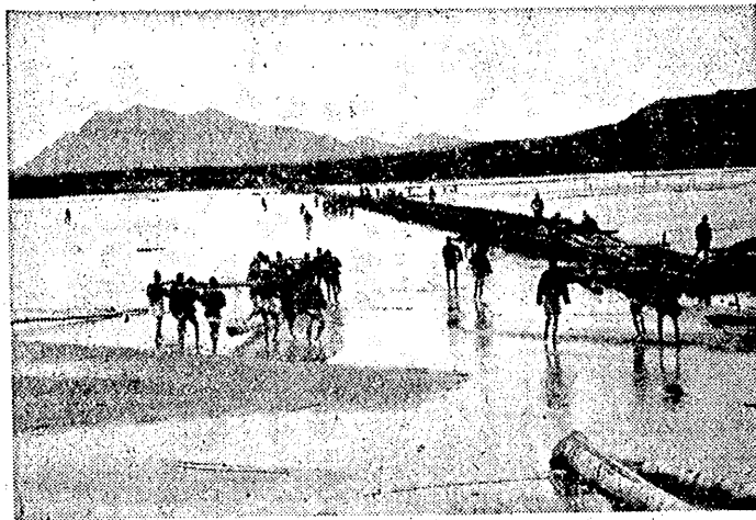
店河の架橋作業
