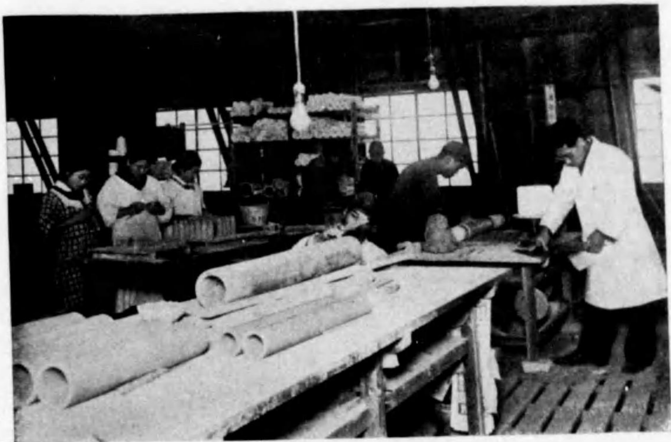
東洋耐火煉瓦株式会社S・M・製品製作工場の一部
