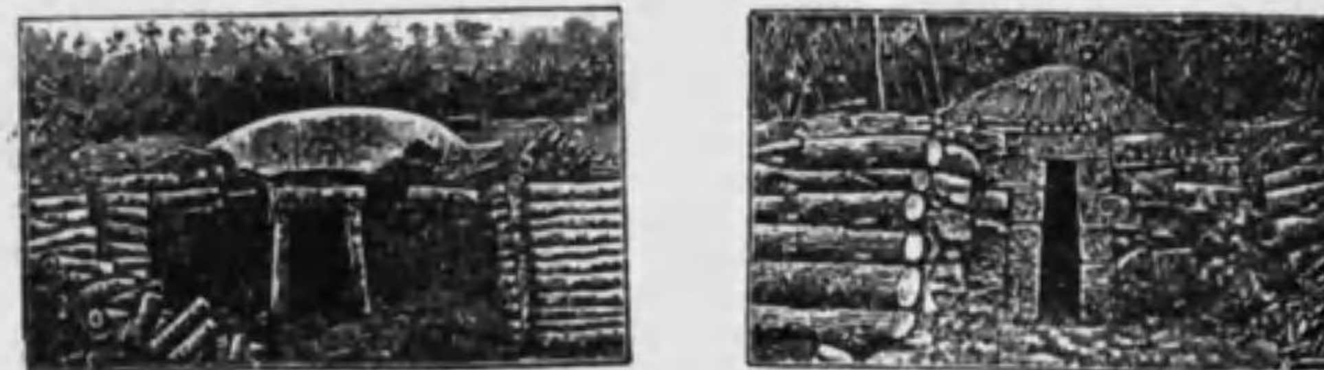
第23圖 我國の炭焼き窯 (左) 土窯軟炭用 (右) 石窯堅炭用
