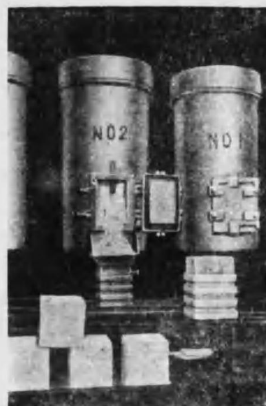
第 29 圖 ドライアイスの製造されたところ
