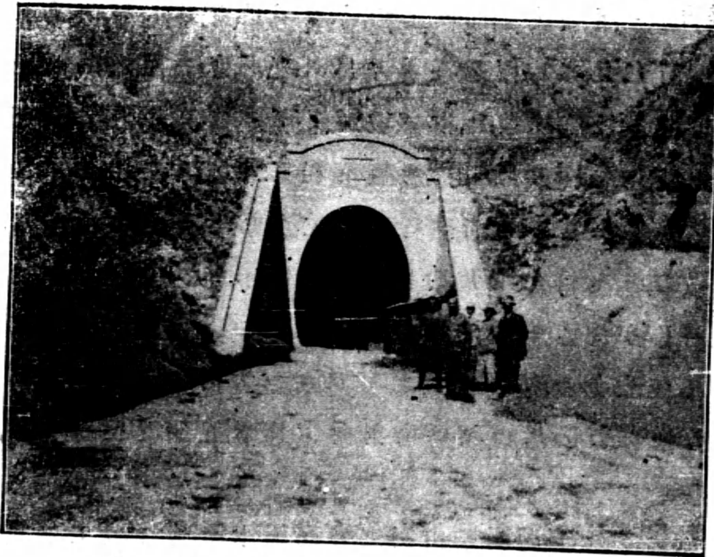
第一圖 盤頭鎮第十四號山洞東口
