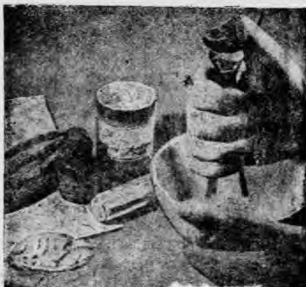
圖6. 製銀塗料。用研鉢研磨硼酸鉛，使成極細粉末，俾與銀粉及膠溶液調成糊狀。
