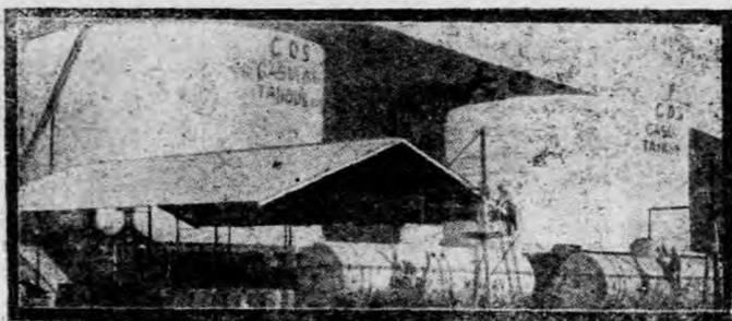
圖 48. 汽油櫃上塗刷銀色油漆，可以減少揮發損失。
