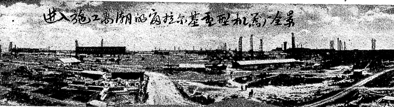
進入施工高潮的蘇拉爾基重型機器廠全景
