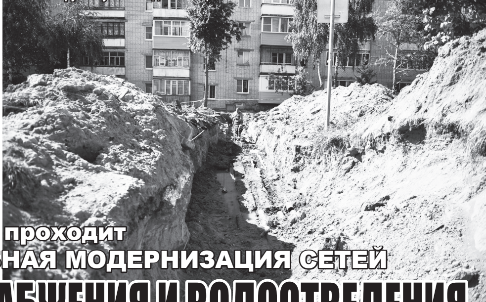
Замена труб на ул. Разведчика Петрова
