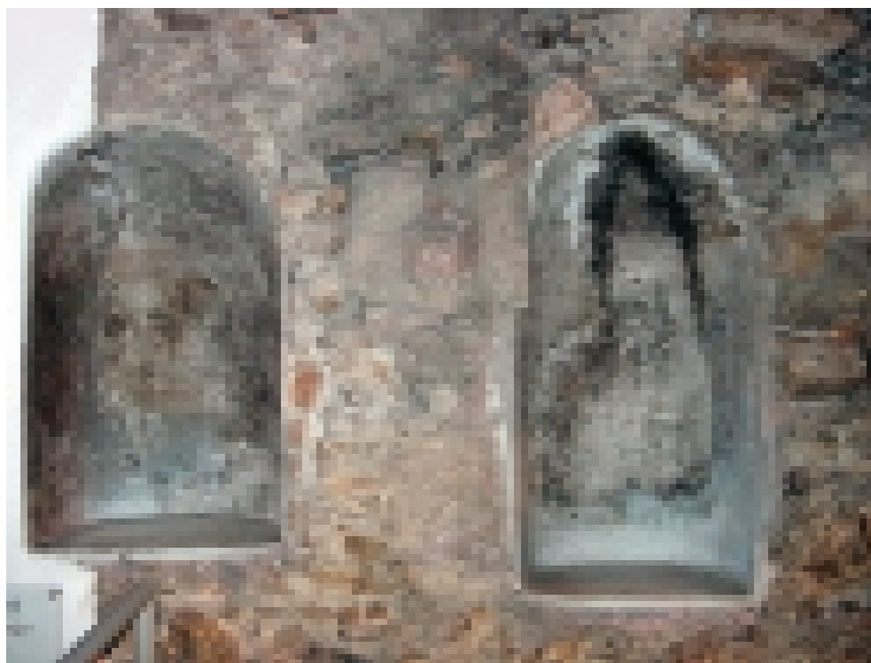
FOTOGRAFIA 12 – Nichos côncavos embutidos na parede da bateria de fornos da Casa da Moeda do Rio de Janeiro, em momento posterior à sua construção original, na forma estilizada do Templo de Salomão. Paço Imperial, Rio de Janeiro. Fotografia de T. Andrade Lima.
