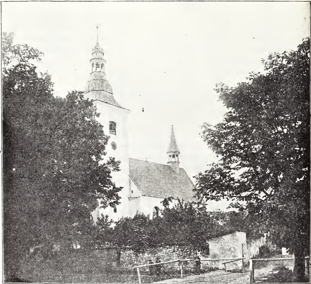
Obr. 29. Kostel v Jezernici.
