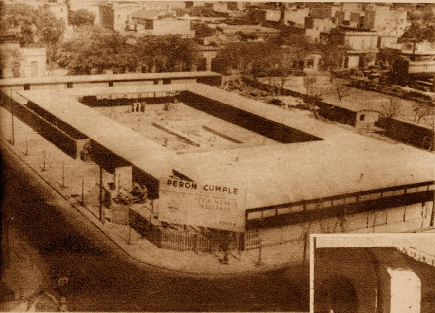
Aspecto de la construcción de la gran Feria Modelo "Belgrano", en Juramento y Ciudad de La Paz.
